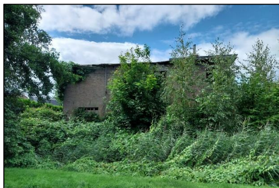
Figuur 2.3. Oostzijde van het gebouw met watergang.
