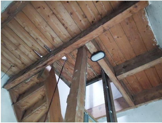
De houten tussenvloer en de betonvloer in de westelijke toren bij de absis.
