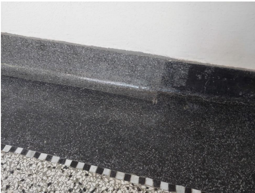
Op sommige plekken is in de plinten herkenbaar waar in het verleden deuren hebben gezeten.
