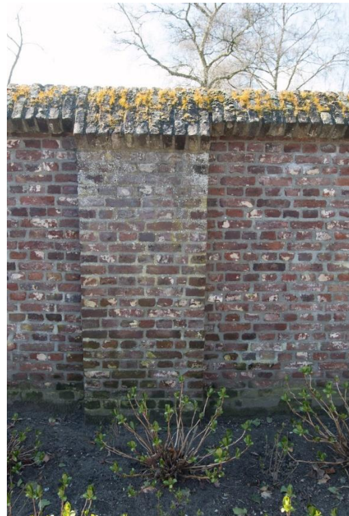
Deel van de kloostermuur dat opnieuw werd opgetrokken. Op de linkerfoto de bouwnaad.
