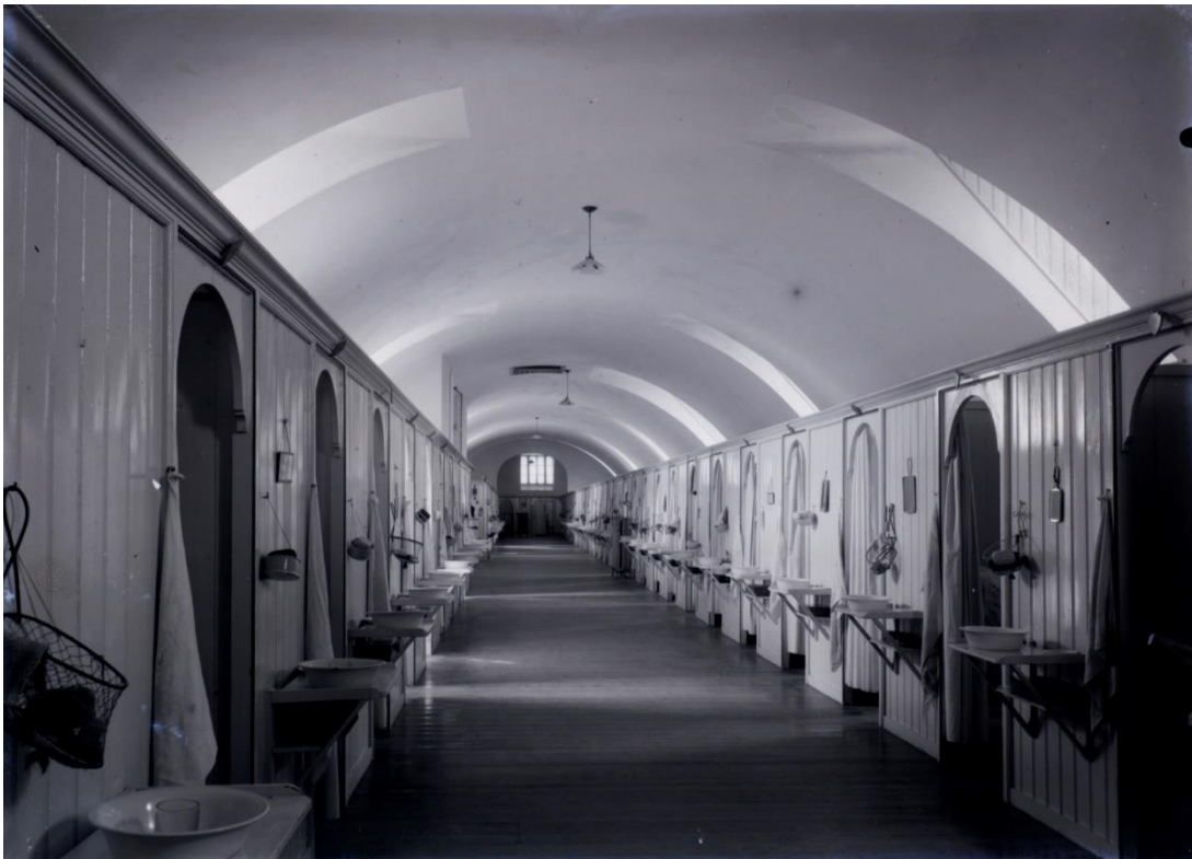
Opname van de cellen op de zolderverdieping, onder het gestucte tongewelf.
