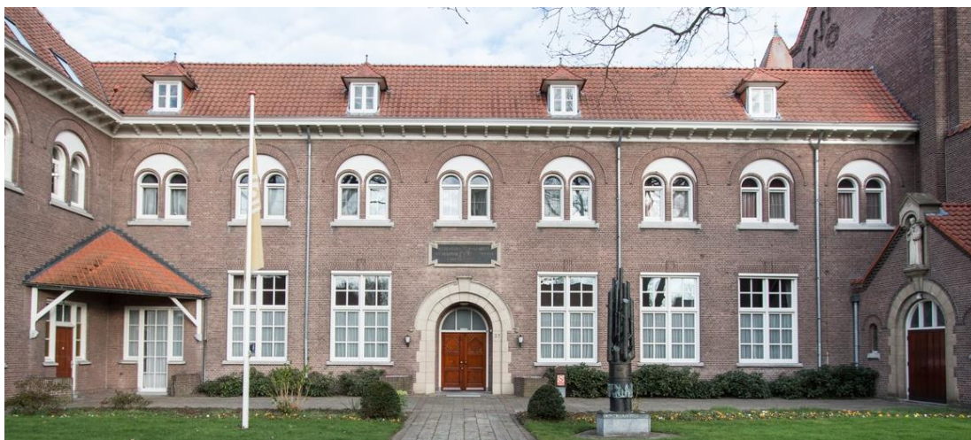
De voorgevel tussen hoekrisaliet en kapel, nu vanaf de straat geopend, oorspronkelijk goeddeels verborgen achter de kloostermuur.
