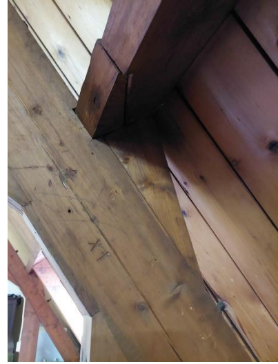
De verbinding van de spantbenen met de bredere dekbalken is gedaan met bout én stripanker. Op de rechterfoto een detail van het spant met het gehakte telmerk XI.
