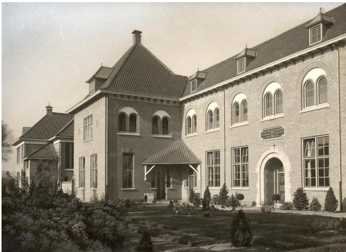
De vleugel begin jaren dertig (rectoraat is al gerealiseerd). Op de tekening is de eerste tuinaanleg te zien. Verder kan worden gewezen op de kleurstelling van kozijnhout (vermoedelijk zandsteenkleur) en de ramen (vermoedelijk grond). Pleisterwerk boven de verdiepingsvensters zou wit kunnen zijn. De ramen op de verdieping scharnieren aan de onderzijde en hebben een driedeling. Het zijn de per twee gegroepeerde ramen van de cellen.
