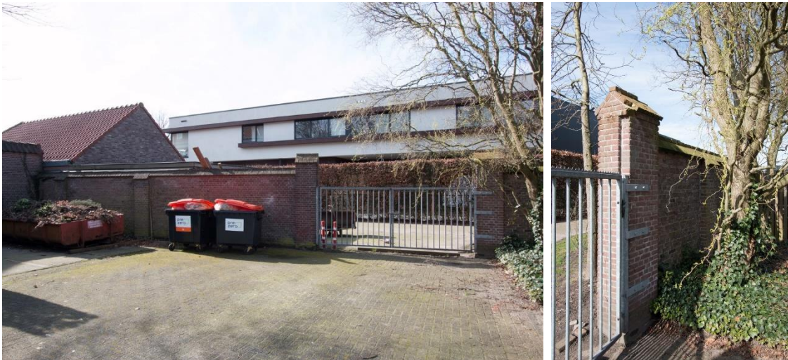
Kloostermuur die de linker begrenzing van het terrein vormt. Hier met oorspronkelijke doorgang tussen hoekleindpijlers.
