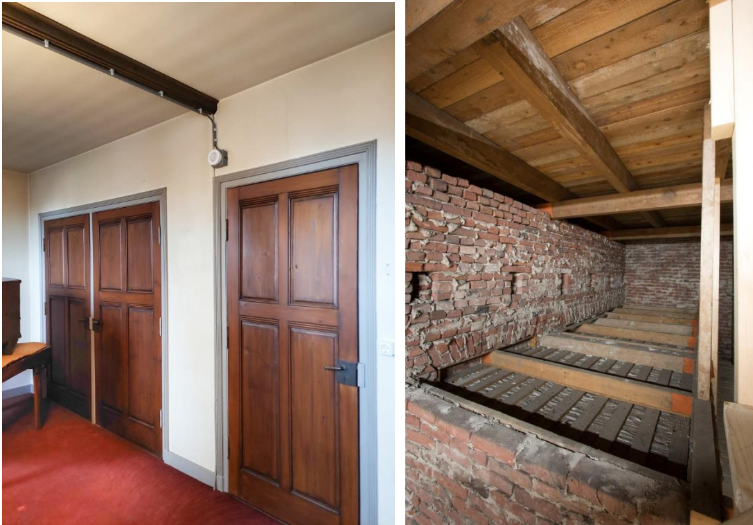
De ruimte op de verdieping met oorspronkelijke deuren. Rechts kijken we op de plafonds van de kasten op de verdieping, waar te zien is dat er sprake is van stucietplafonds.
