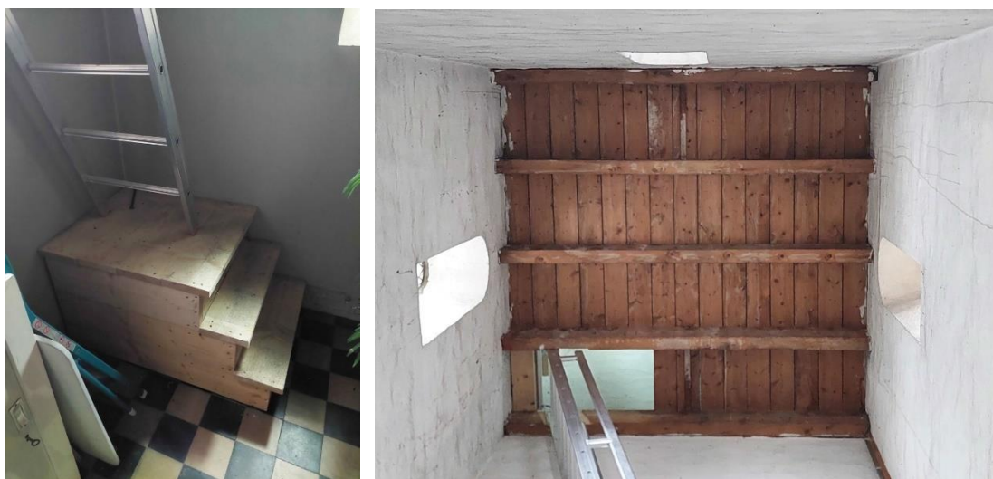
De vloeren in de oostelijke traptoren. Links de begane grond, rechts één van de tussenvloeren.
