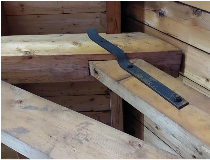
De verbinding van de spantbenen met de bredere dekbalken is gedaan met bout én stripanker. Op de rechterfoto een detail van het spant met het gehakte telmerk XI.
