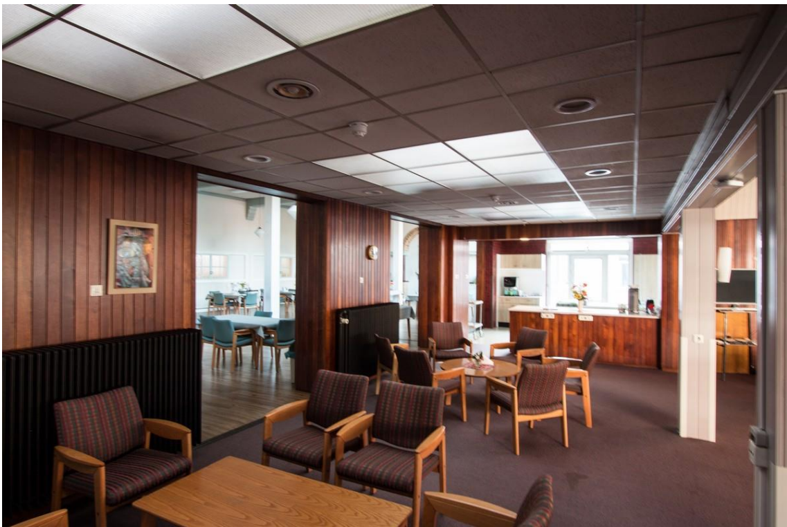
De recreatieruimte heeft een verlaagd plafond gekregen. Wandbekleding is uit 1974.
