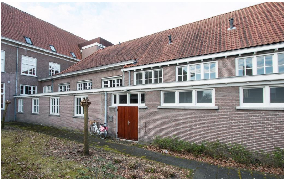
Het deel van de gang uit 1925 is gereconstrueerd, waarbij een nieuwe vensterindeling tot stand werd gebracht.
