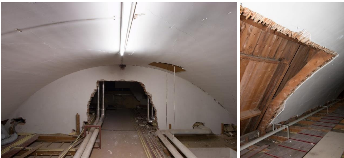
Deel van de zolder waar het tongewelf nog redelijk intact is. Rechts schade aan het plafond.
