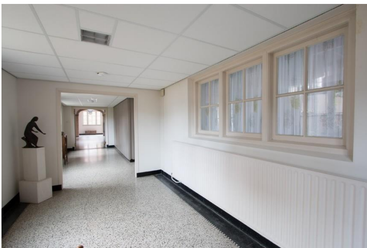
De gangvloer is ter plaatse van de voormalige refter omhoog gebracht. Dit is waarop op de overgang naar het vroegere gymnastieklokaal een trap tot stand is gebracht die er oorspronkelijk niet is geweest.
