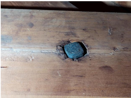
Geen ringen bij de moeren. Rechts het potloodopschrift 'boven' op één van de trekbalen.
