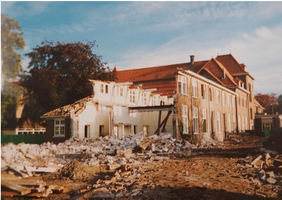
De sloop van de novicenvleugel.
