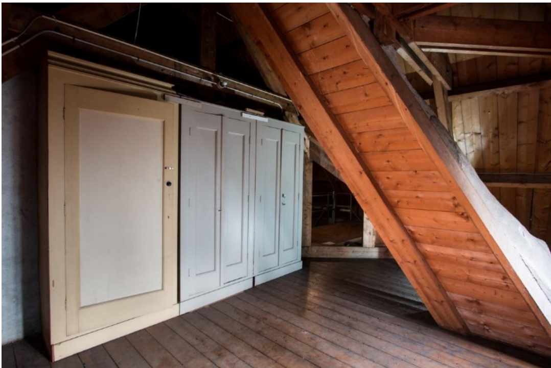
Kasten op de zolder. Versleepte rookkanalen uit de bouwtijd.
