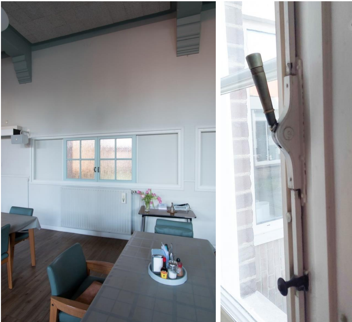
De schuiframen vanuit de eetzaal gezien. Rechts een espagnolet uit 1924.
