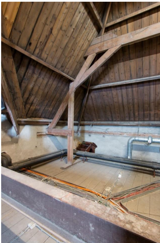
Detail van de constructietekening uit 1922 (let op het waterreservoir) en de thans bestaande toestand met op de voorgrond de stalen balk waarop het reservoir rustte.
