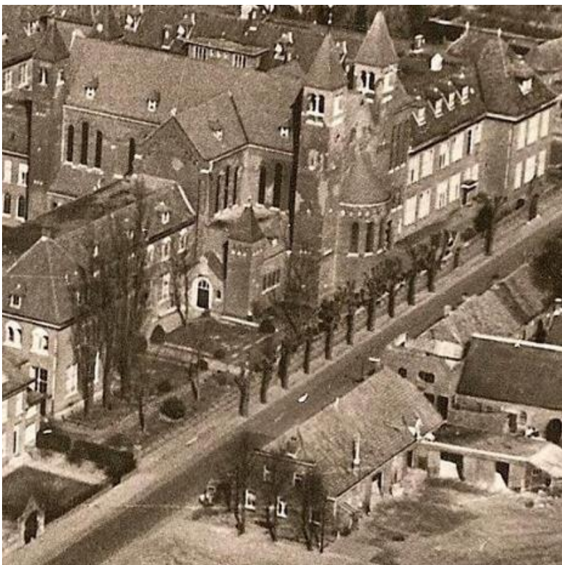
Luchtfoto uit omstreeks 1950 waarop is te zien dat de planten in de tuin tot wasdom zijn gekomen en de structuur in de tuin nagenoeg ongewijzigd is gebleven.
