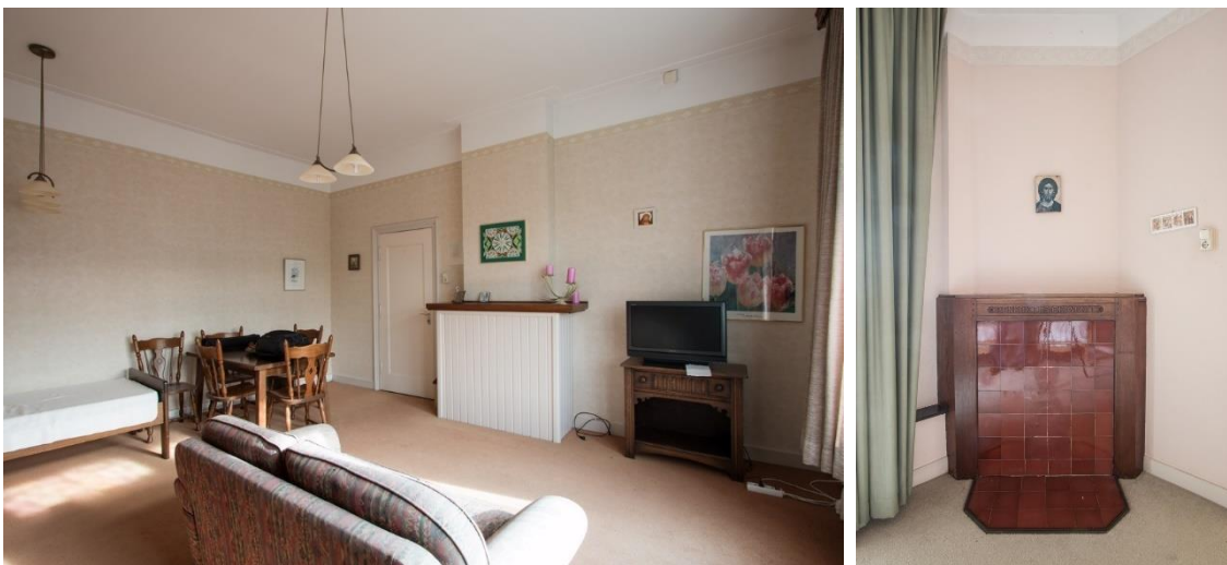
De voorkamer op de verdieping met omtimmerde stookplaats en eenvoudig stucrietplafond. Rechts de hoekschouw in de achterkamer.
