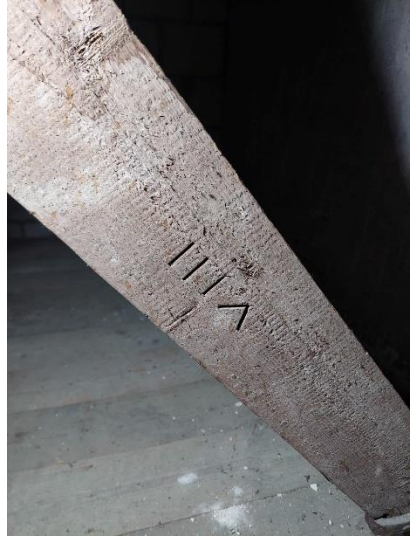
Overblijfsel van de kapconstructie, sterk aangepast. Op de rechter foto het telmerk VIII.
