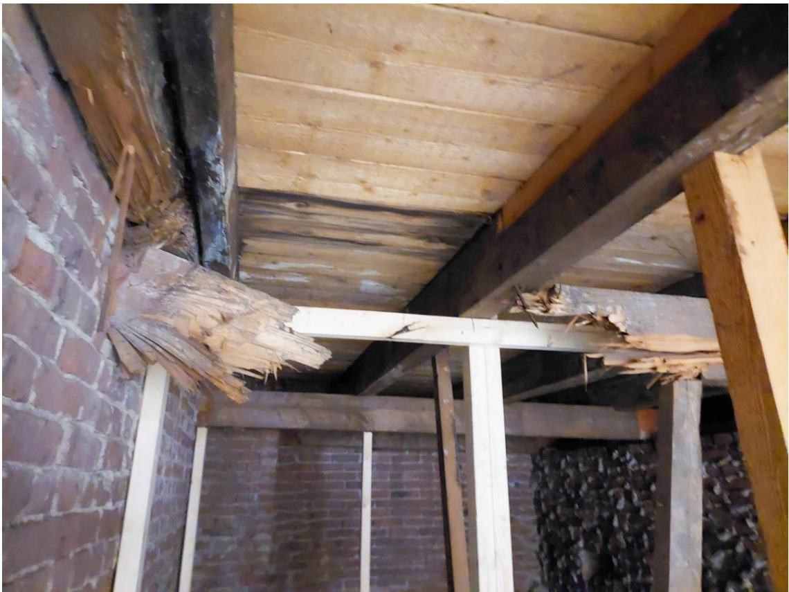
Herinnering aan de oorlogsschade, een door granaatinslag versplinterde balk.
