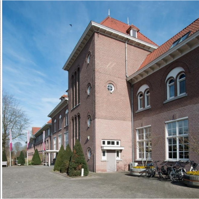
Sporen van de verdwenen entree tot het trappenhuis, in de vorm van recenter metselwerk dat lichter van kleur is. Rechts nieuwe metselwerk daar waar oorspronkelijk het éénlaags deel van het washuis aansloot.
