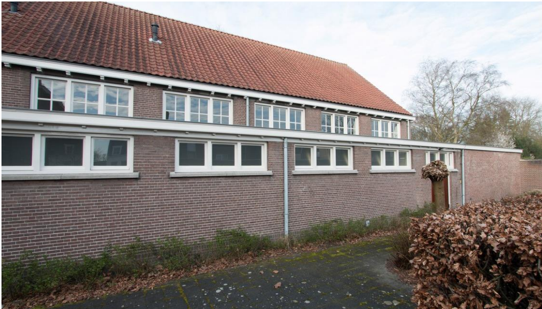
De gang langs het gymnastieklokaal met geheel rechts de voormalige toestelberging en kleedruimte aangebouwd.
