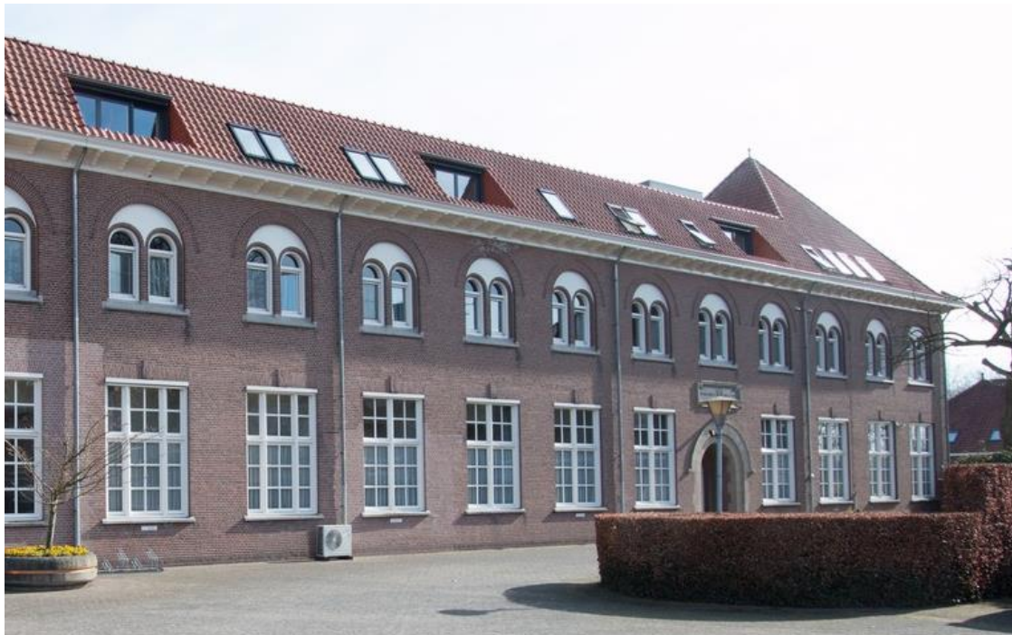
De zijgevel van het bouwdeel uit 1923 (bestektekening). Grote verandering is de sloop van aanbouwen rond een open plaats, ter plaatse van de bakkerij. Na de sloop is muurwerk aangeheeld, wat nu nog te zien is aan de hand van in kleur lichtere baksteen. Dit aanheelwerk is vrij zorgvuldig uitgevoerd. Grote verandering is het vernieuwen van ramen en het aanbrengen van terrassen en dakramen op de zolder. Dakkapellen zijn gesloopt.
