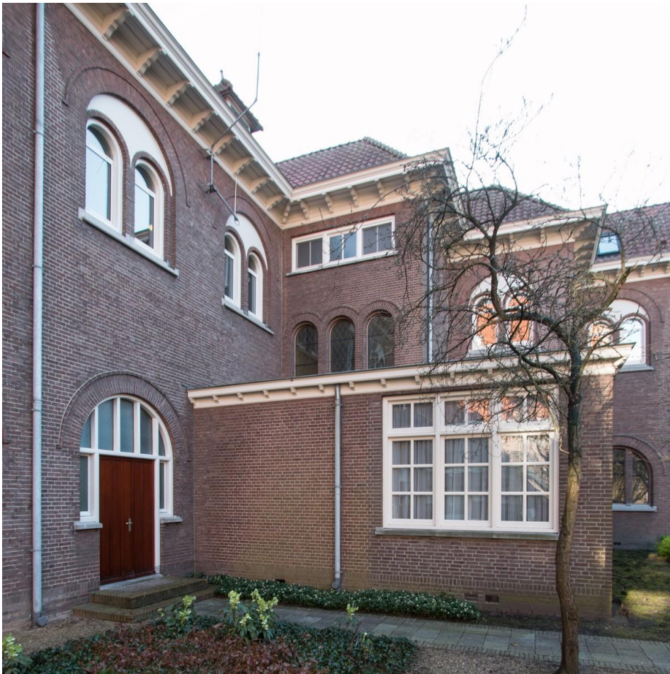
Het trappenhuis en de uitbouwen daartegenaan. Rechts van de hemelwaterafvoer tekent zich een verticale bouwnaad af. Het metselwerk links daarvan oogt recenter van datum.
