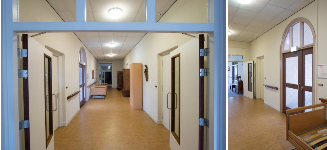
De middengang op de verdieping, boven het bidkoor, gezien door een recente pui in de richting van de kapel. Rechts de vernieuwde toegang tot het oude trappenhuis.
