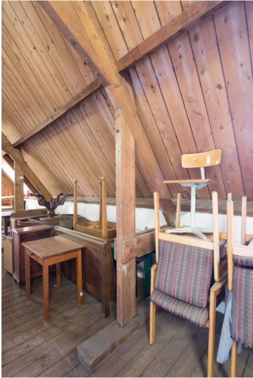
De verticale stijlen zijn zowel gespijkerd als gebout. Hier moeren met hexagonale kop.
