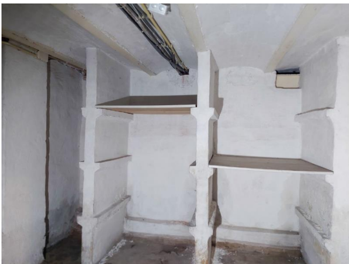
De legruimten in de kelder.
