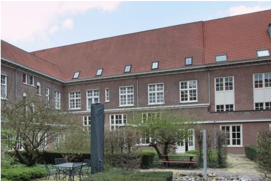
De gevel aan de tweede kloostercour.
