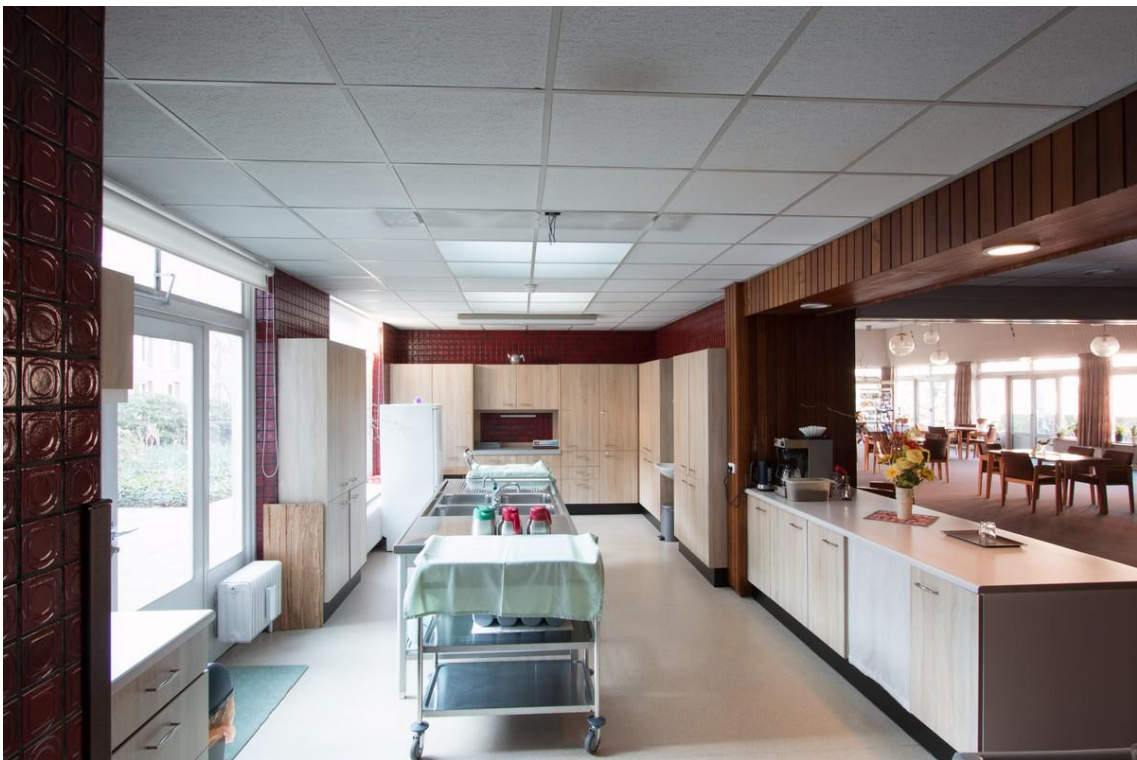
De afwaskeuken uit 1974 heeft de oorspronkelijke functie verloren. Op de wanden nog wel tegelwerk uit die tijd. Vloerafwerking en verlaagde plafonds van latere datum.
