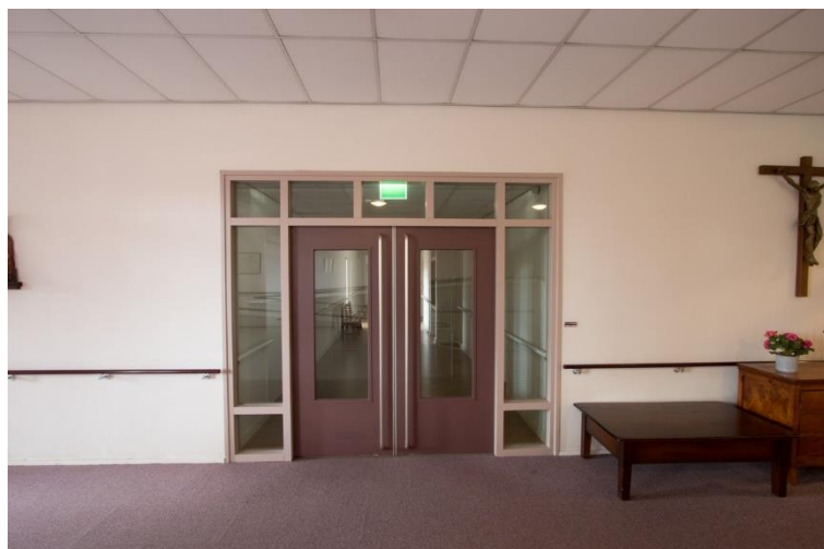
De liftschacht is aangebouwd in 1974. Rechts op de foto met de liftdeuren een tot deuropening vermaakte vensteropening waarin oorspronkelijk glas-in-lood was gevat. Op de rechterfoto de pui die is geplaatst op het moment dat de middengang werd gecreëerd.
