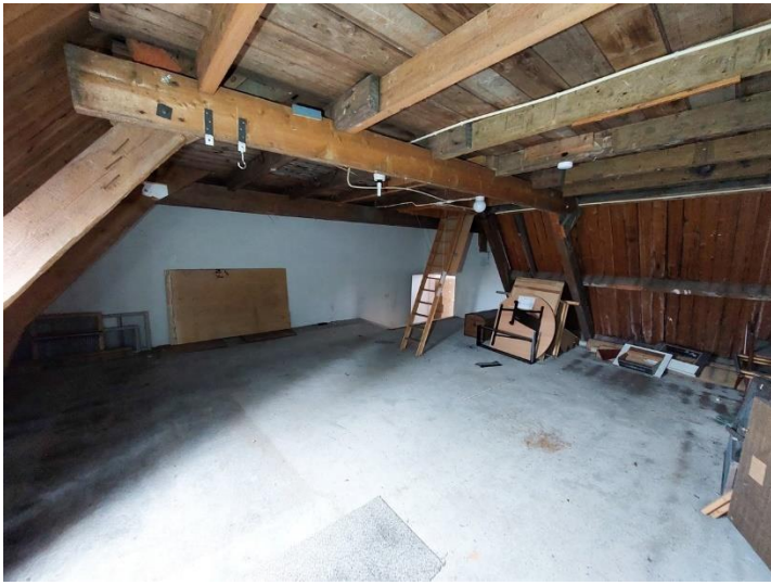
Overblijfsel van de kapconstructie, sterk aangepast. Op de rechter foto het telmerk VIII.
