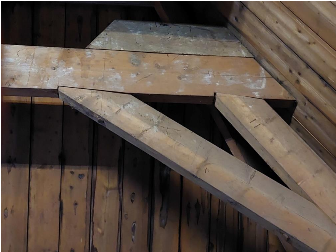
Detail van de constructie met gehakte merken II.
