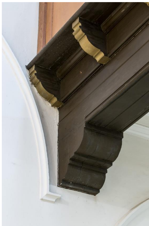
Deel van het platte dak van de sacristie (boven de kasten van de voormalige gerfkamer). Rechts de met hout omklede stalen balk van het zangkoor.
