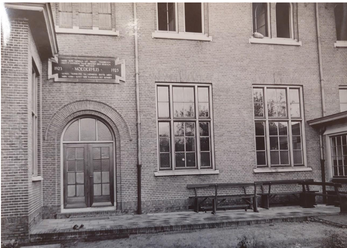
Vroege opname van een deel van de gevel. Bij de verdiepingsvensters is zijn de wanden tussen de vensteropeningen nét te zien. Iedere cel had de beschikking over één venster.
