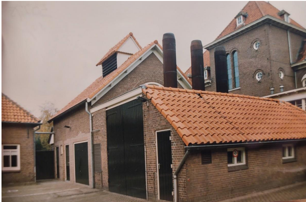
Was- en ketelhuis kort voor de sloop in de jaren negentig. De schoorsteen die op oude luchtfoto's is te zien, was eerder al gesloopt.
