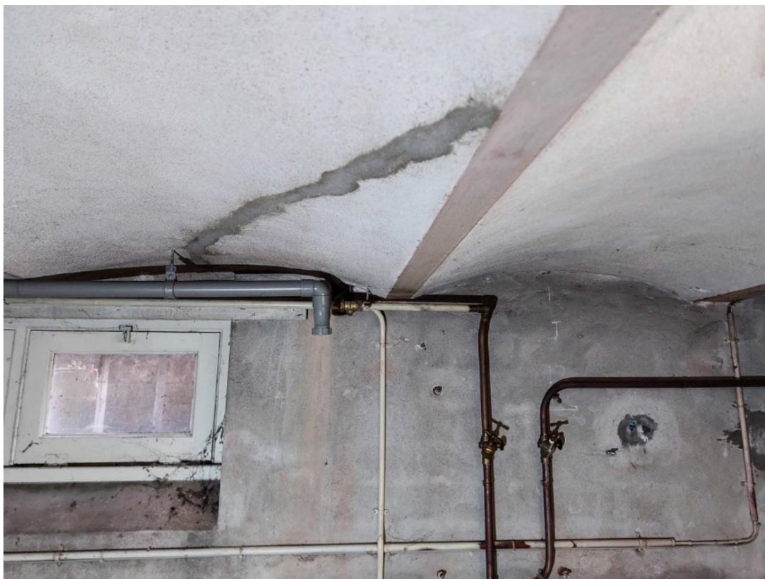
De constructie van het kelderdek.
