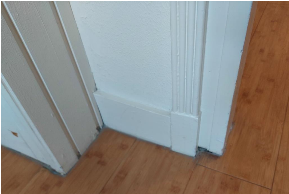
De oorspronkelijkheid van enkele deurkozijnen (en delen van de gangmuur) is ook vast te stellen aan de hand aan enkele oorspronkelijke profiellijsten en houten neuten.
