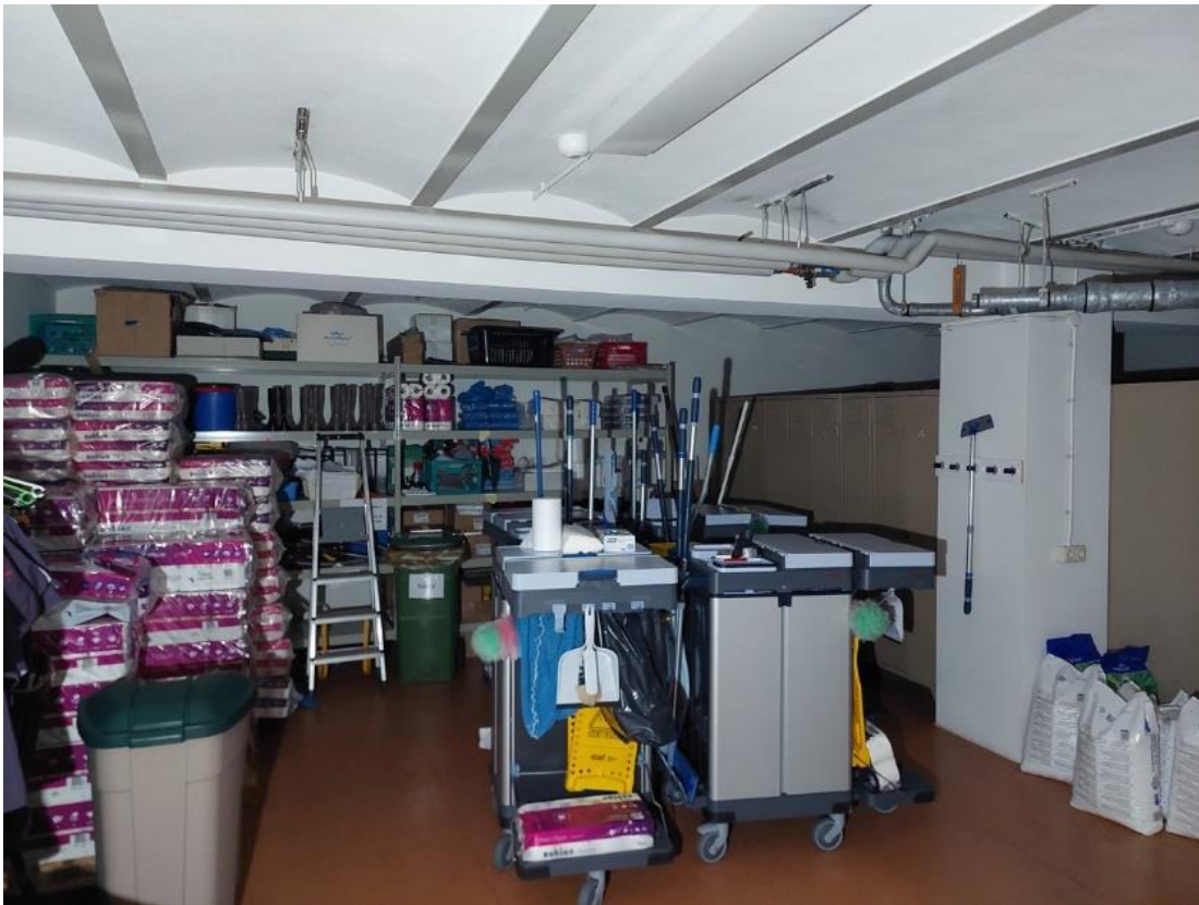
Deel van de kelder waar de constructie van kolommen, balken en het kelderdek is te zien.
