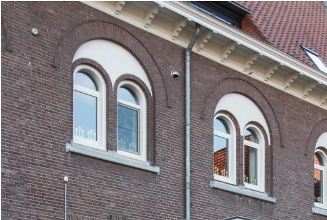
De rechtervensteropening heeft traceerwerk in baksteen (evenals de twee vensters rechts hiervan), behorende bij het vroegere oratorium voor novicen op de verdieping. Let ook op verschil in detaillering van de boogvulling.
