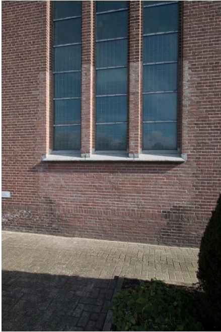
Sporen van de verdwenen entree tot het trappenhuis, in de vorm van recenter metselwerk dat lichter van kleur is. Rechts nieuwe metselwerk daar waar oorspronkelijk het éénlaags deel van het washuis aansloot.
