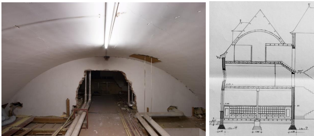
Boven het plafond van de zolder zijn nog restanten van het stucietplafond uit 1925 aanwezig. Rechts het gewelf in dwarsdoorsnede. De doorsnede toont ook de lambrisering in de recreatiezaal voor novicen.
