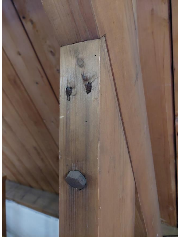
De verticale stijlen zijn zowel gespijkerd als gebout. Hier moeren met hexagonale kop.
