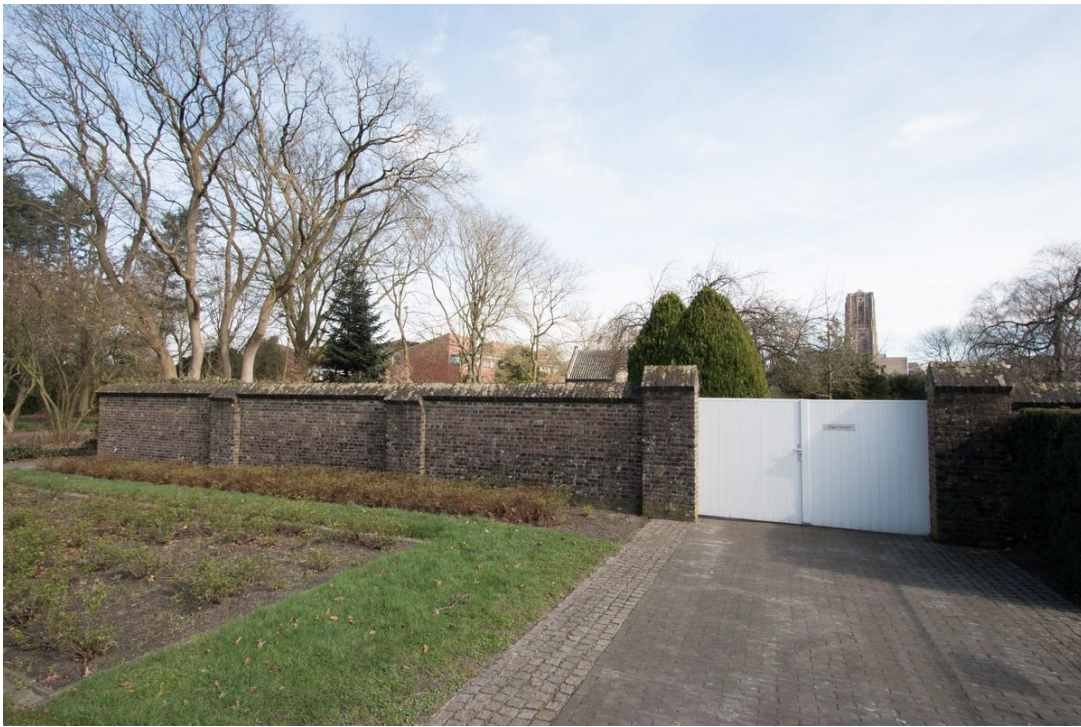
Deel van de muur dat werd vernieuwd, vermoedelijk tijdens de verbouwing in de jaren negentig.
