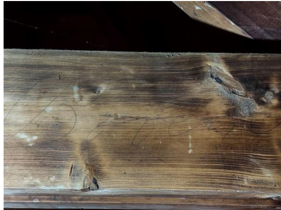
Geen ringen bij de moeren. Rechts het potloodopschrift 'boven' op één van de trekbalen.
