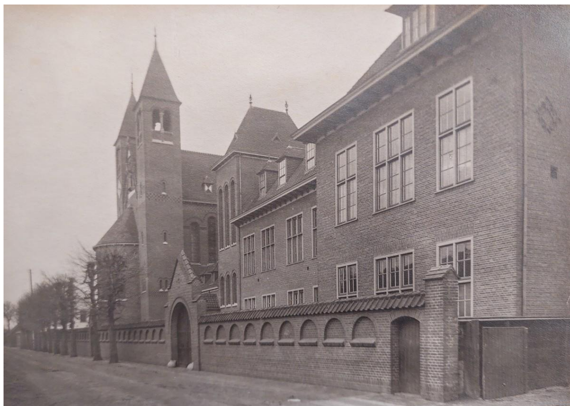
Opname waarop de bouwdelen uit 1909-1911 vanaf de straat zijn te zien. De kloostermuur is ook uit die tijd.
