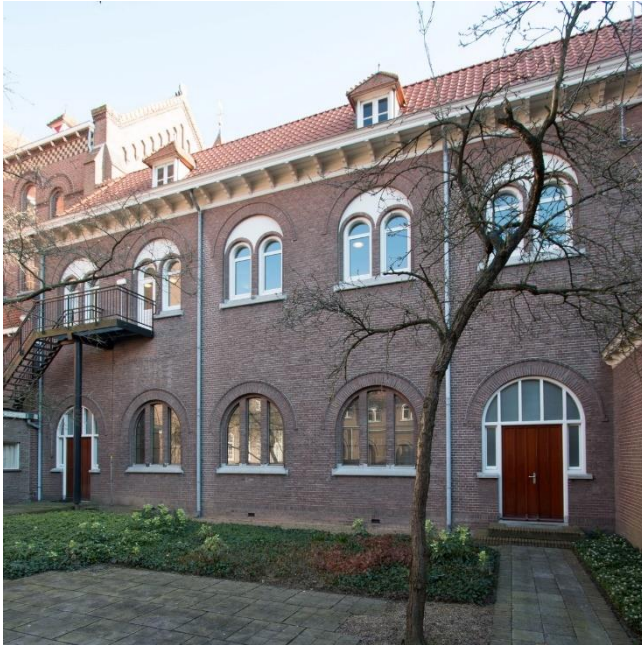
De gevel aan de kloosterhof in de huidige toestand.
