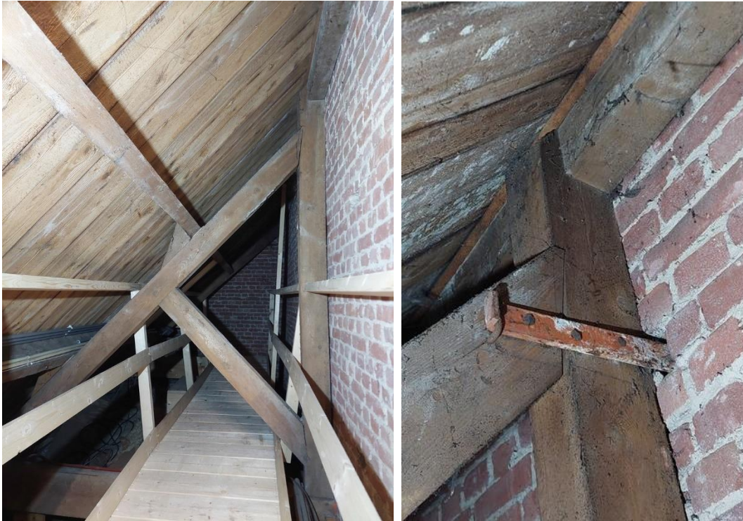
Eén van de spanten boven één van de zijbeuken. Rechts nokdetail en verankering aan de muur.
