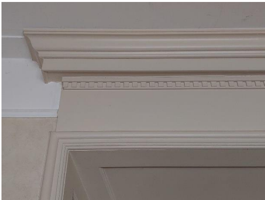
Detail van de kroonlijst boven de suitedeuren (niet bijzonder fraai, want wat topzwaar) en rechts één van de rolluikkasten boven de vensters op de begane grond.
