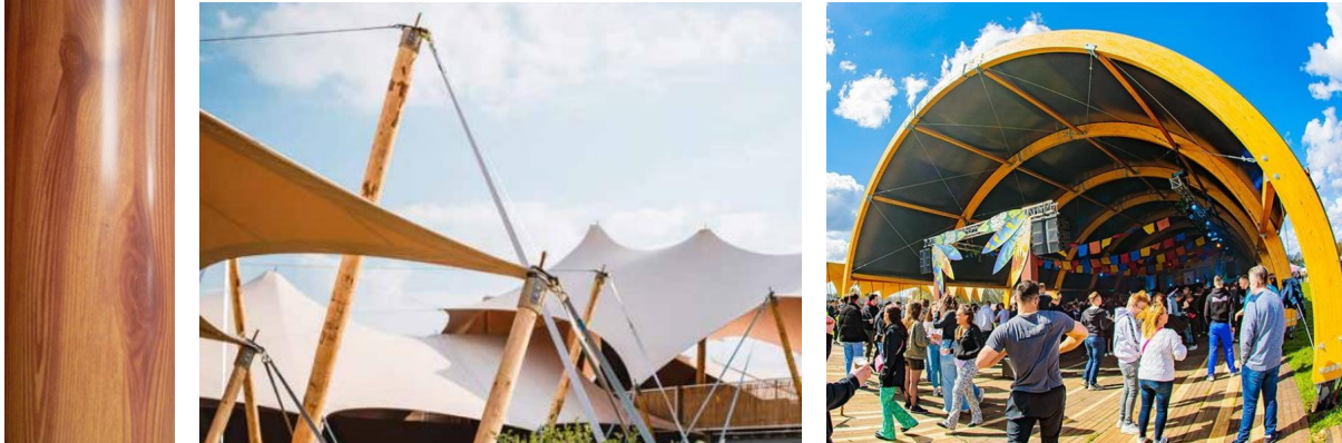
Figuur 18 Voorbeelden van houttoepassingen in eventstructuren: houtnerf gecoat aluminium (l), rondhouten stammen (m), gelamineerd houten liggers (r).
