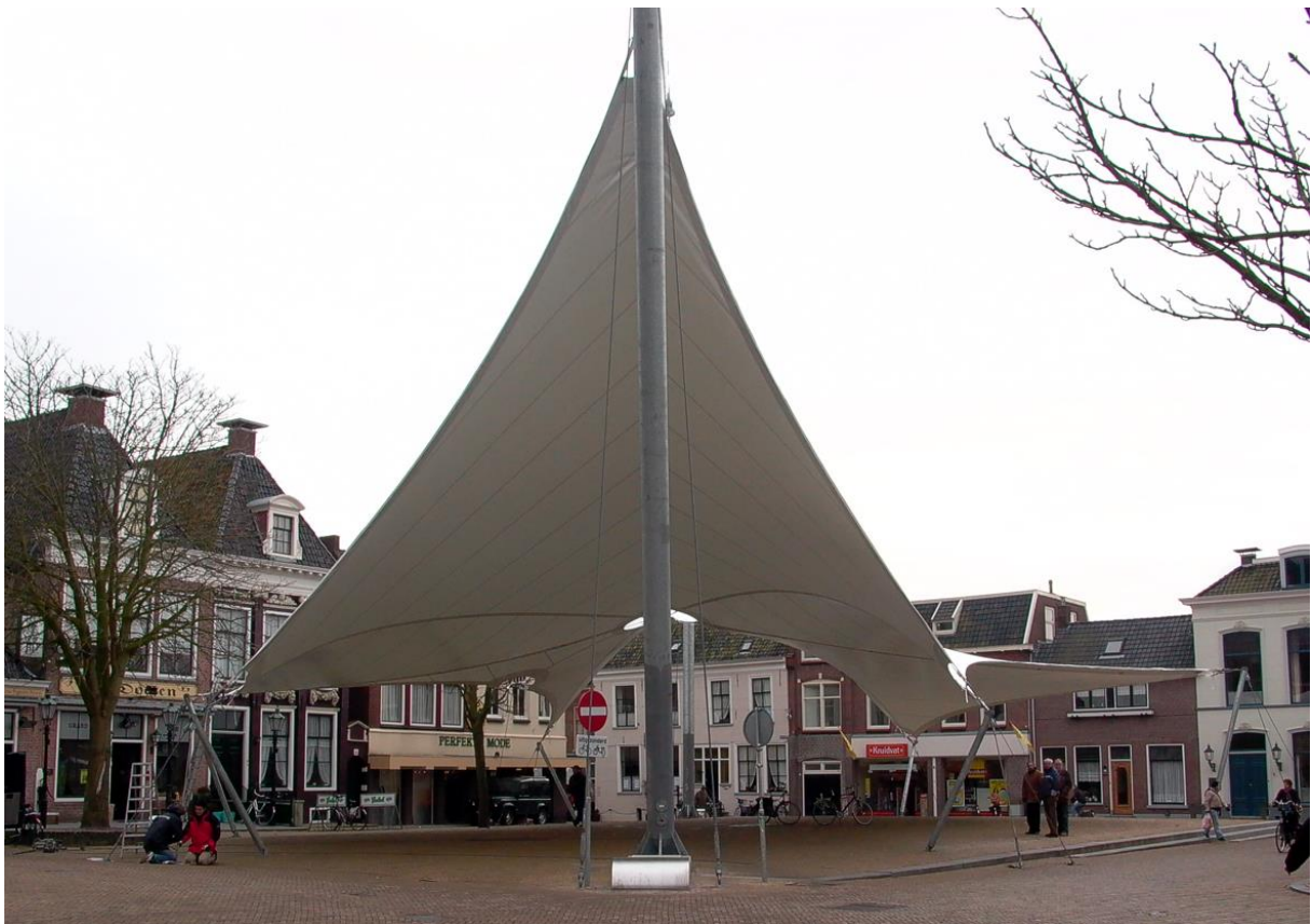
Figuur 2 Doorzicht van de Voorstraat richting de Dijkstraat – huidige tentconstructie.
