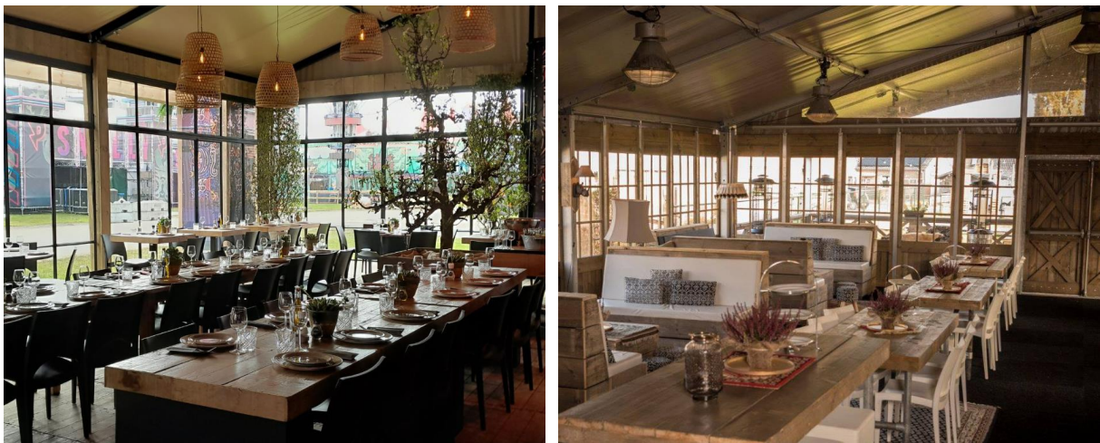
Figuur 17 Voorbeelden van glasgevels met stalen kozijnen (links) en houten kozijnen met roedeverdeling (rechts) (Van Vught).
