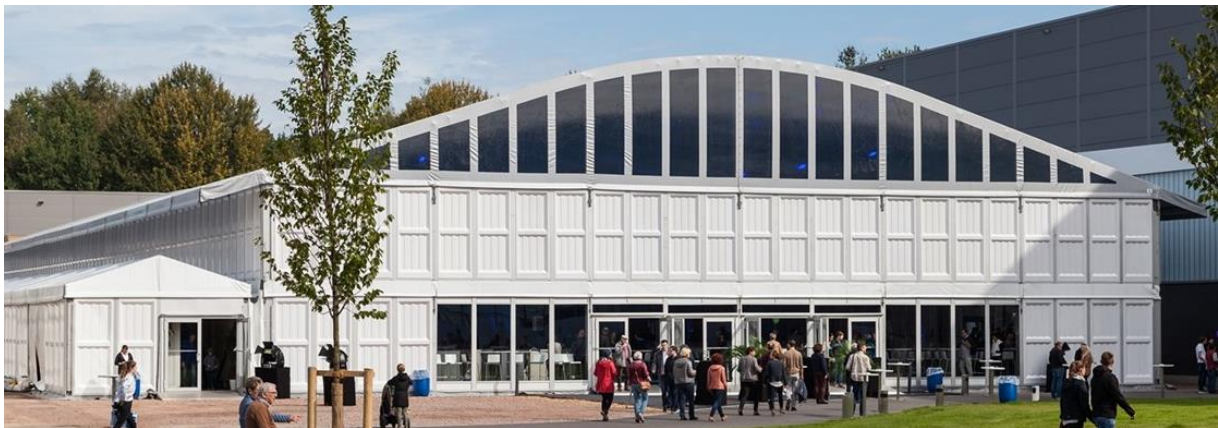
Figuur 16 Combinatie van glaspanelen (onder), kunststof wandpanelen (midden) en een doekfaçade (boven) (Losberger De Boer).
