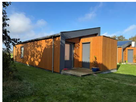
op nr. 135: 4 tijdelijke woonunits waarvoor verplaatsing is aangevraagd.
