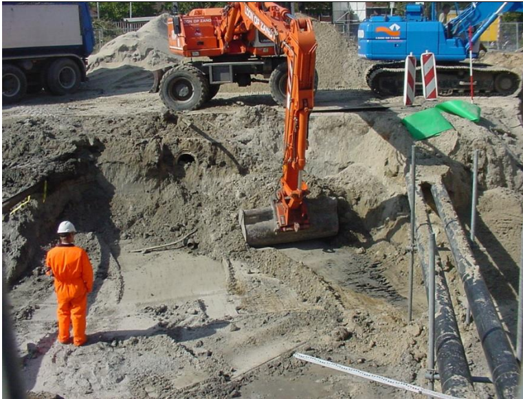
Figuur 9.1 Sanering door middel van ontgraving
