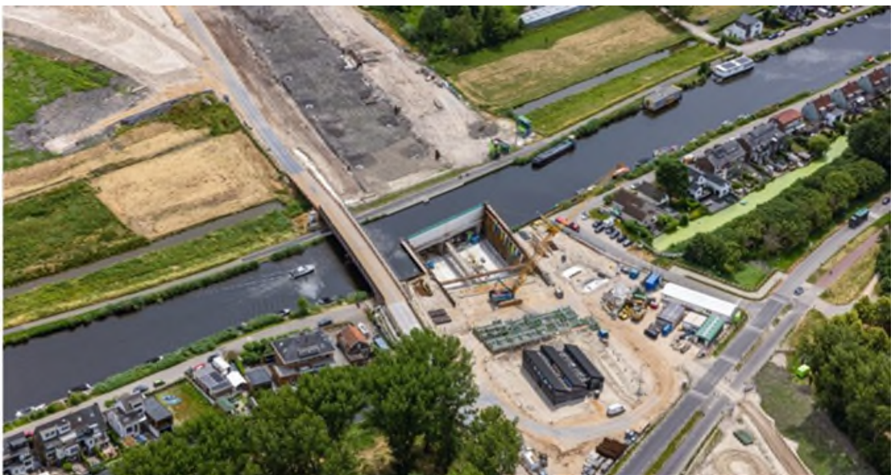
Aanleg tunnel onder de Rotte. Foto: Rijkswaterstaat
