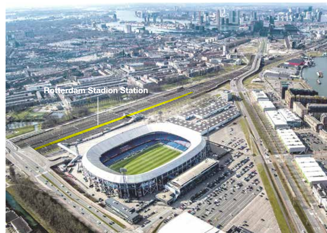
Evenementenstation Rotterdam Stadion
