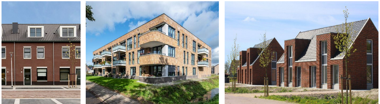
Links: beneden-bovenwoningen met gelijkvloerse entree benedenwoningen. Midden: kleinschalig appartementencomplex met levensloopbestendig. Rechts: grondgebonden nultredenwoning.
