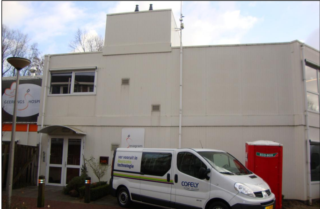
Het tijdelijke hospice, gezien vanuit zuidwestelijke richting (westgevel)
