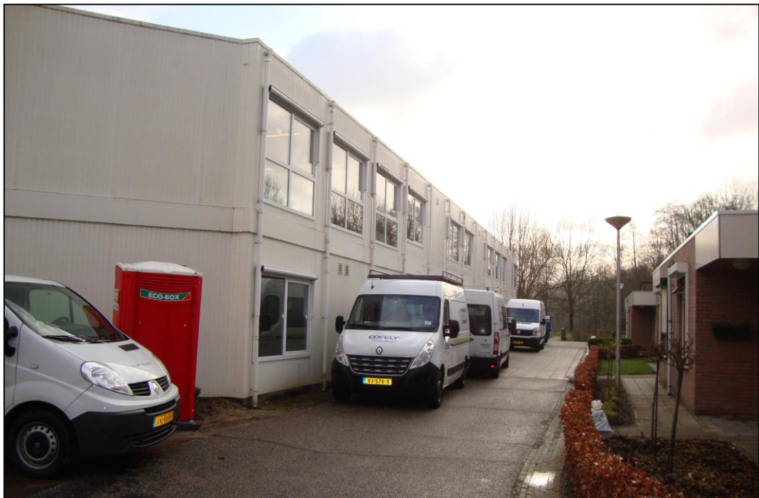
Het tijdelijke hospice, gezien noordwestelijke richting (westgevel). Op de foto rechts zijn de woningen aan de Oosterbeemd 20 t/m 23 zichtbaar.
