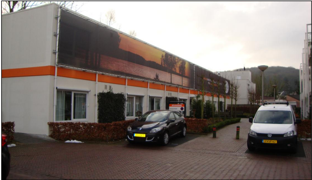
Het tijdelijke hospice, gezien vanuit noordwestelijke richting (westgevel)
