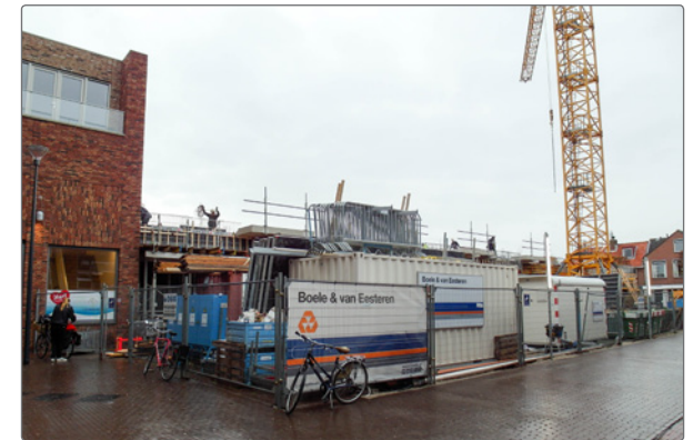
Fase 3 in aanbouw
