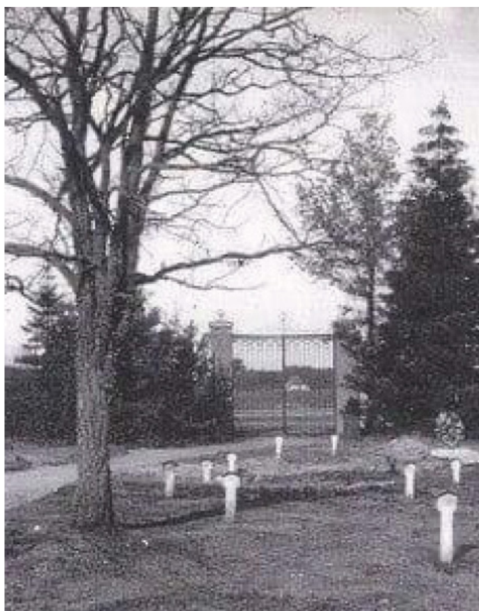
Ongedateerde foto van de oorspronkelijke hoofdingang aan de Groteweg. Goed zichtbaar is het negentiende-eeuwse ijzeren entreehek tussen gemetselde pijlers voorzien van pironnen. Bron onbekend.
