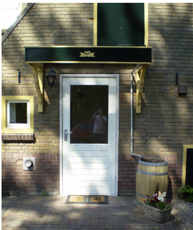
Foto uit 2024 van achtergevel. Goed zichtbaar zijn de recentelijk aangebrachte glasdeur en luifel daarboven. Het kleine raampje links bevindt zich ter plaatse van het oorspronkelijke toilet, dat in een secundaire bouwphase is weggebroken.
