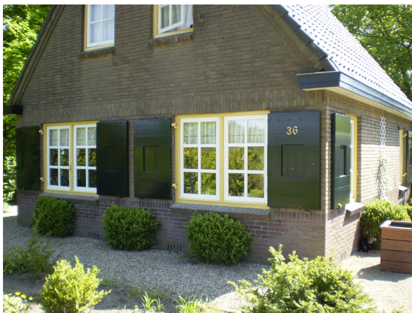
Foto uit 2024 van de voorgevel. Goed zichtbaar is de decoratieve 'gevelband' gevormd door de vensters, luiken, gevelplint en doorgaande rollaag boven de vensters.
