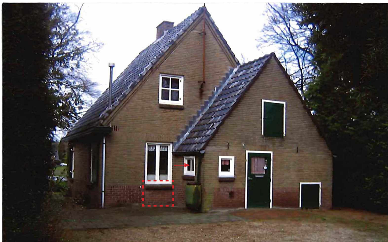
Foto uit 2004 van de achtergevel. Oorspronkelijk bevond zich in de achtergevel van het hoofdvolume nog een achterdeur (ter plaatse van de bijkeuken). In een secundaire bouwphase is deze verbouwd tot raam. Het 'stalraampje' bij de rode pijl is daar wellicht bij een tussentijdse verbouwing herplaatst bij het wegbreken van het privaat aan de achtergevel. Goed zichtbaar is het hooiluik in de topgevel en mestluik rechts onder in de gevel van de voormalige stal.
