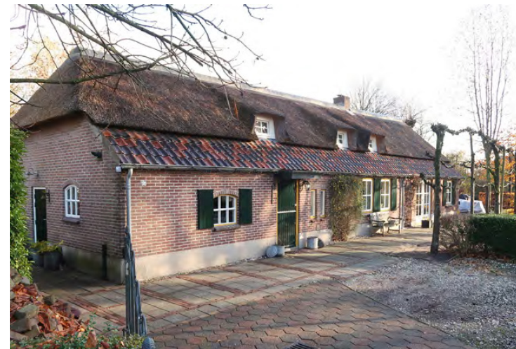
Van oudsher aanwezige langgevelboerderij - Nieuwstraat 37
