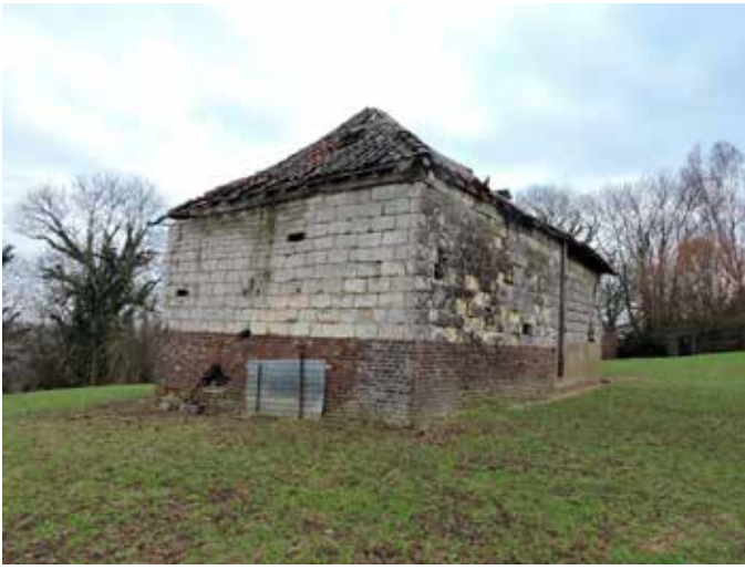
1. Het schuurtje aan de noordkant: de bakstenen sokkel en de muur in mergel stammen uit dezelfde bouwfase. Het hergebruik van materiaal wordt geïllustreerd door de kleine blokjes mergel, linksboven. Linksonder zit een reparatie met zelfgemaakte betonstenen
