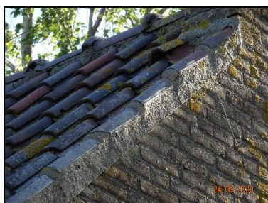
Figuur 20. Detailfoto van de kantpannen. Zichtbaar is de met specie afgesloten rand.
