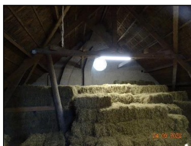
Figuur 7. De hooizolder van de grote opstal. Alle ramen in de opstal zijn gesloten.
