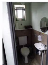
Toilet ruimte berging
