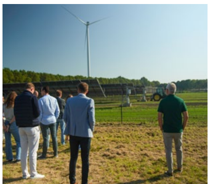
Agri-PV Symbizon (foto: Vattenfall)
