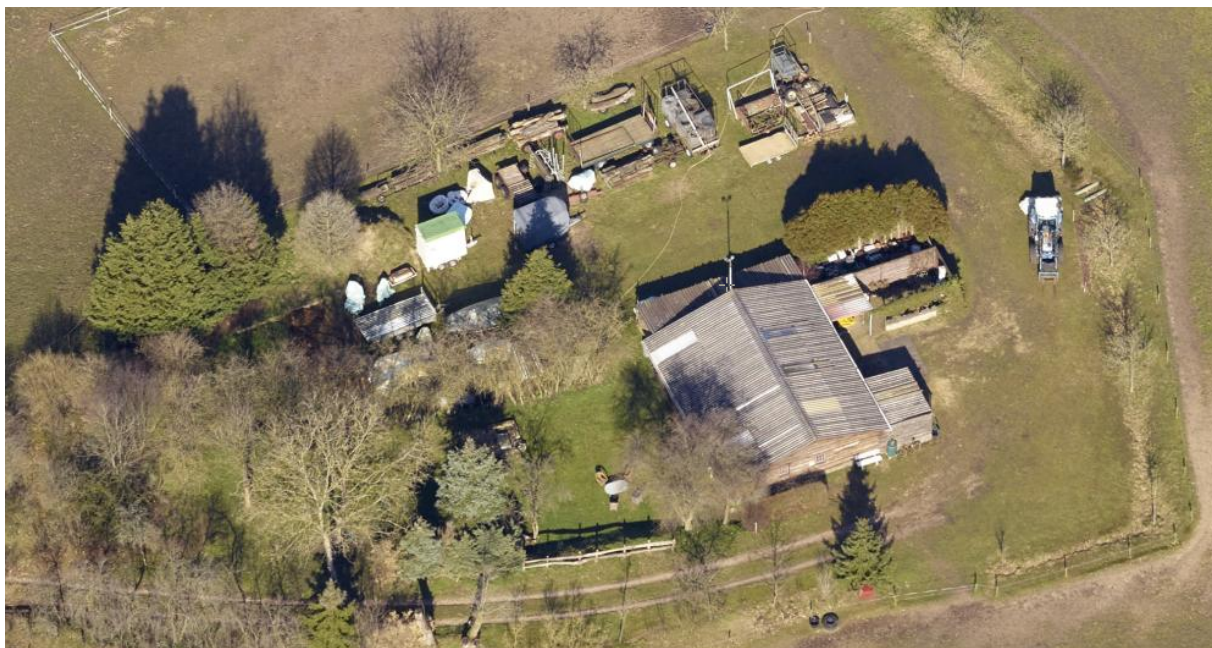
Impressie paardenstal en buitenopslag binnen plangebied
