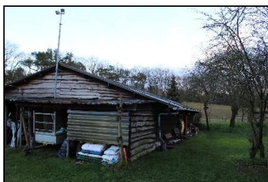
Figuur 4. Noordaanzicht paardenstal/opslagschuur.
