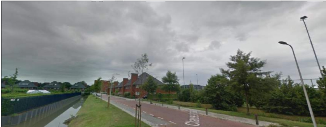
Figuur 1: Planlocatie (links) met aan de overzijde van de weg sportpark Velo – google.nl/maps
