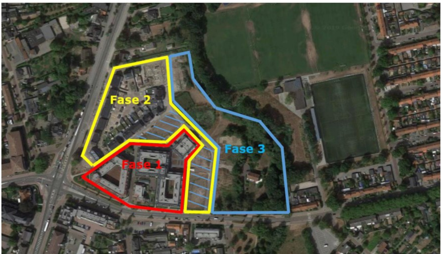
Luchtfoto met fasering uitvoering. Dit bestemmingsplan heeft betrekking op fase 3 (blauw omlijnd) en de blauw gearceerde delen van fase 2.
