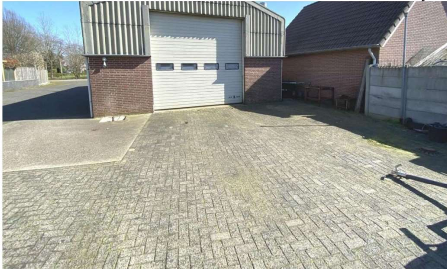
foto 5: tankplaats en ondergrondse dieseltank
