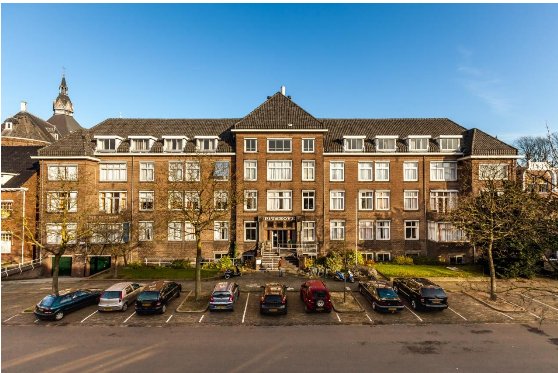
Voormalig klooster Piushove in bestaande toestand
