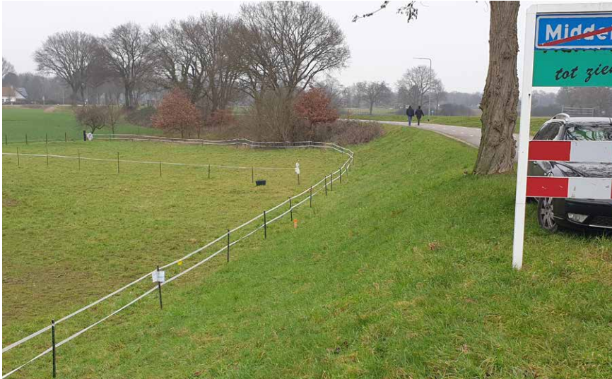
Dijk met beplanting op het talud, duidelijk hoogteverschil zichtbaar
