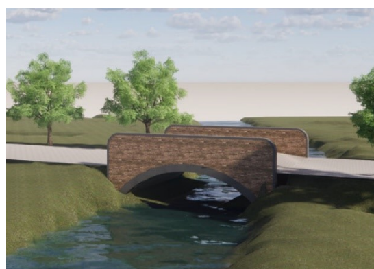
Nieuwe brug, inclusief faunapassage. Borstwering wordt lager uitgevoerd
