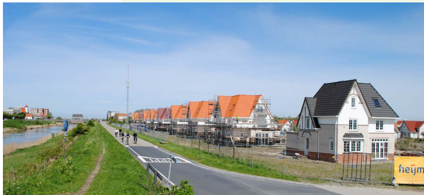
Tijdens de bouw van recreatiepark Cavelot
