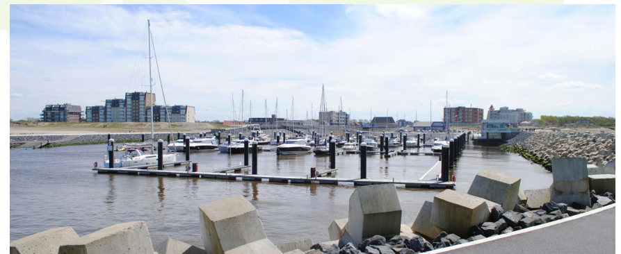
De nieuw aangelegde Jachthaven Cadzand
