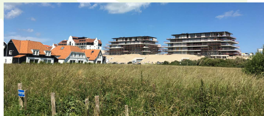
Hotel De Blanke Top met de bouw van de Blanke Top appartementen
