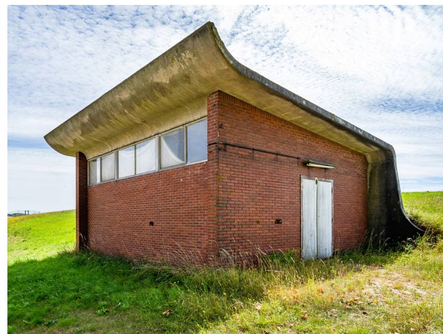
Figuur 3.2.9 | Het zuidelijke hevelgebouw
