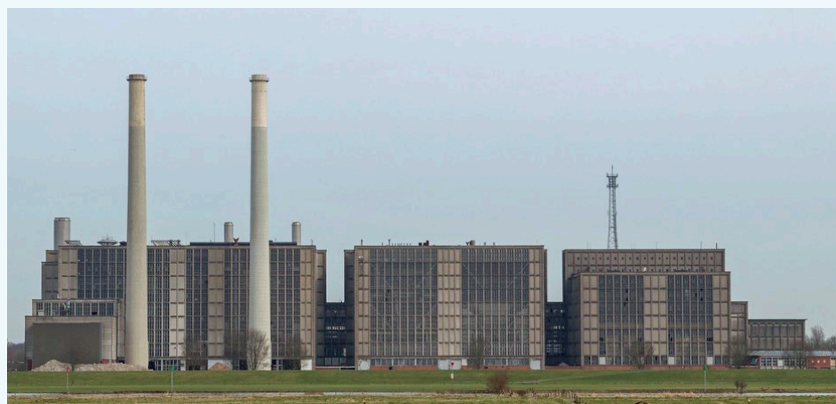
Figuur 5.1.7 | Aanzicht IJsselcentrale vanaf de IJsselszijde
