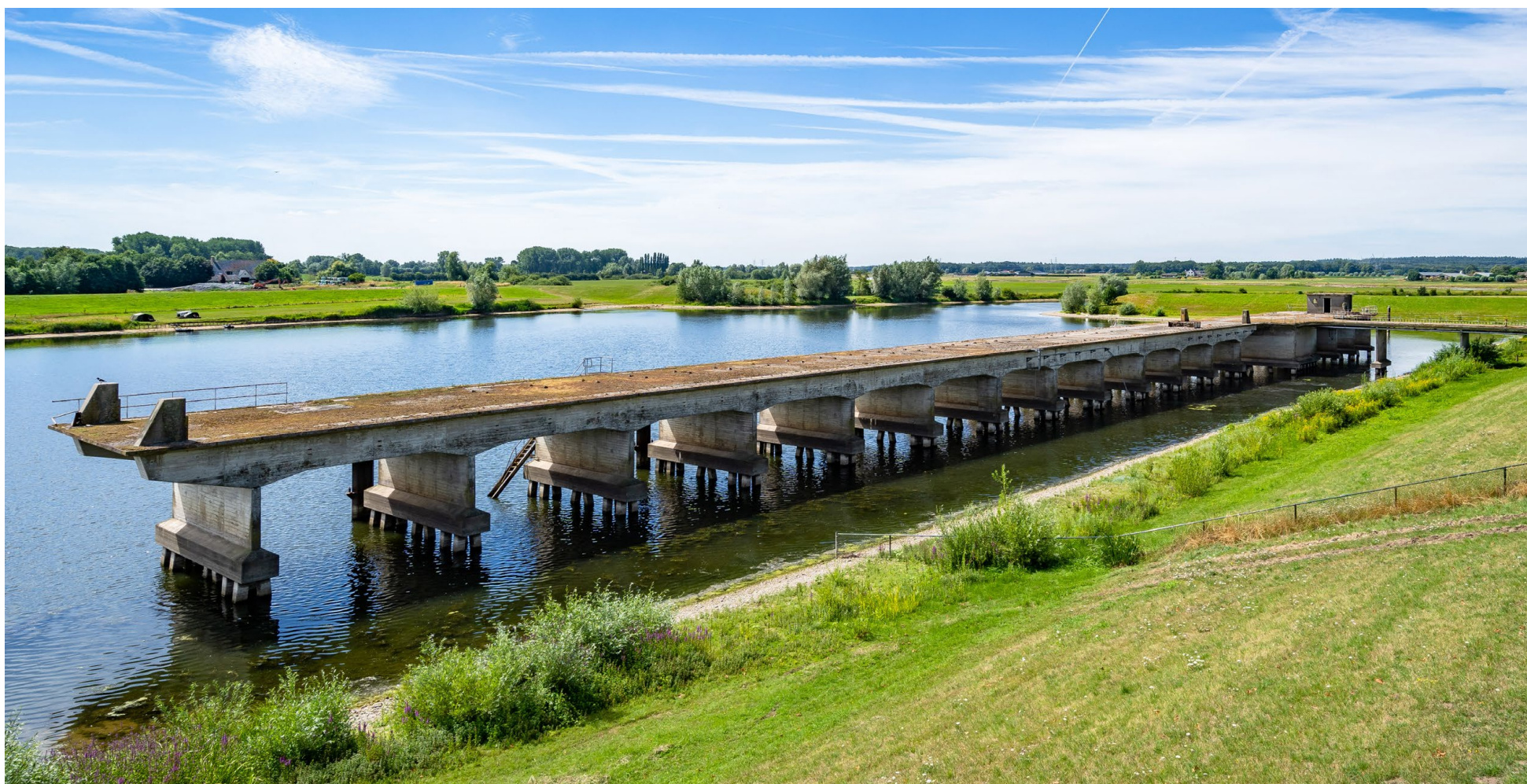
Figuur 3.2.4 | De betonnen steiger in de zuidelijke insteekhaven
