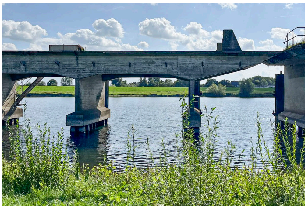
Figuur 3.2.8 | De steiger in de zuidelijke insteekhaven
