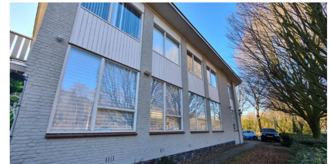
Figuur 9: Gevel te slopen pand aan Helvoirtseweg
