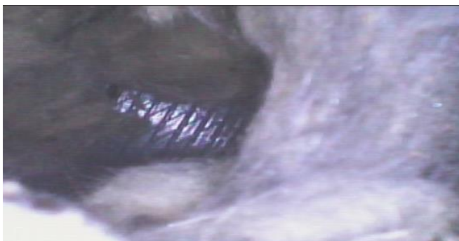
Figuur 6: Isolatiemateriaal achter de open stootvoegen
