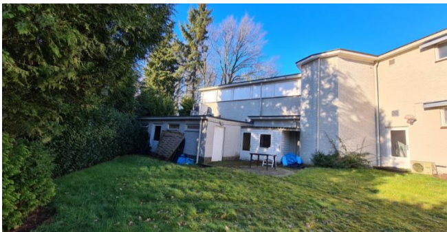
Figuur 7: Achterkant te slopen pand gezien vanaf de binnen tuin
