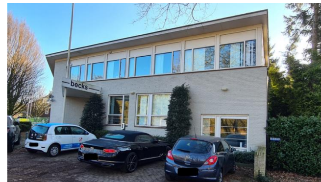
Figuur 2: Westgevel van het kantoorpand
