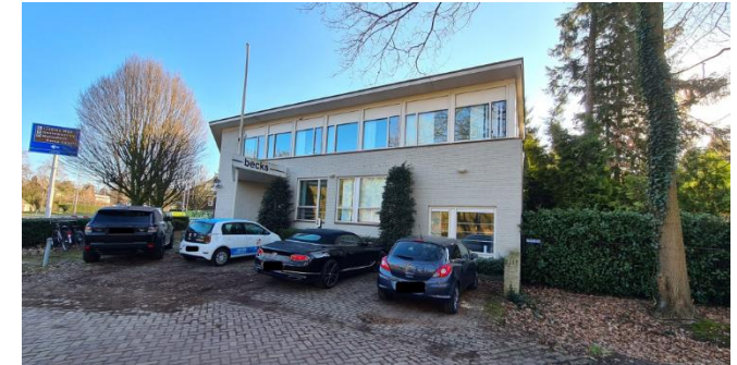
Figuur 5: Te slopen pand gezien vanaf Hoevenessestraat
