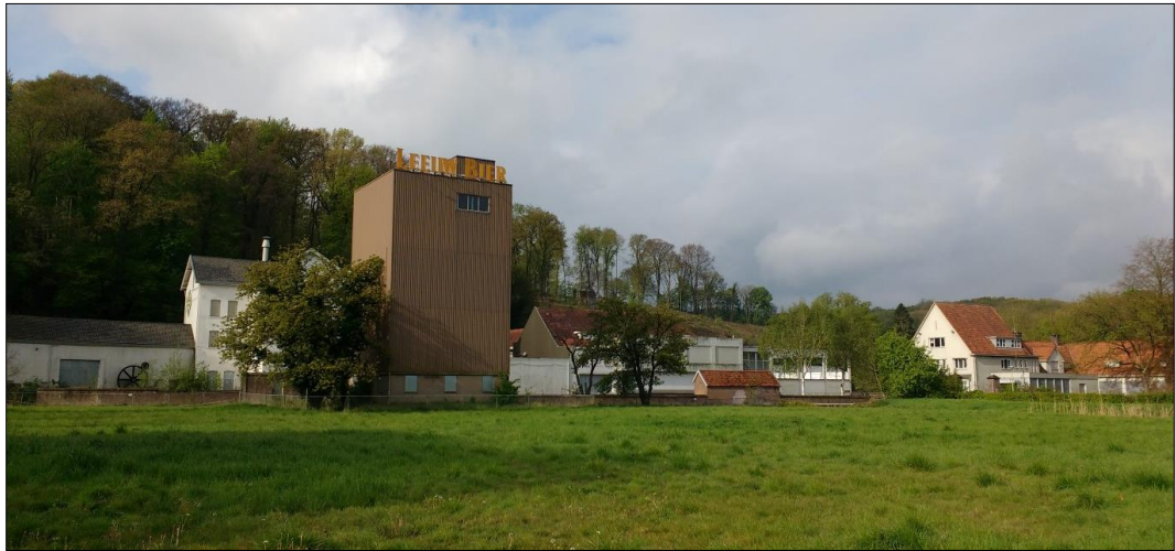
Zicht op de bebouwing op het Leeuwbierterein, gezien in zuidwestelijke richting, met centraal de te slopen moutssilo.
