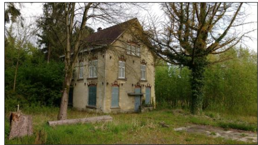
De te renoveren villa aan de zuidwestzijde van het plangebied.
