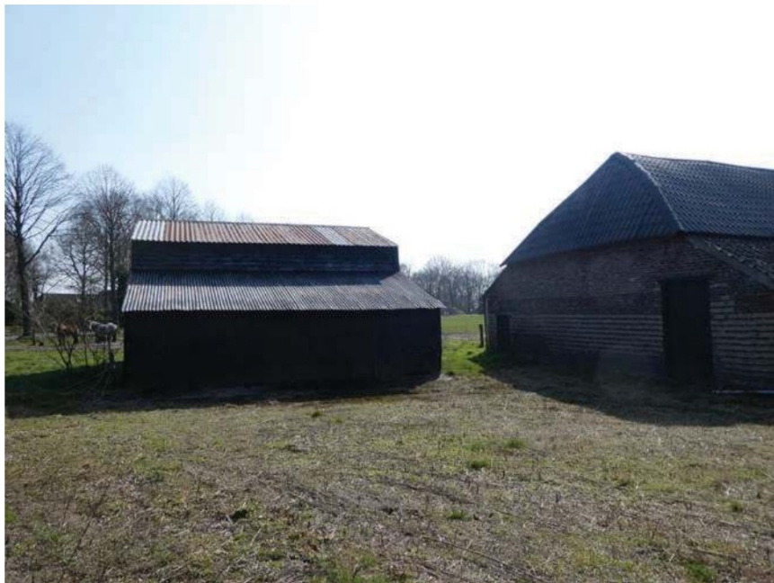
Veldschuur, exterieur noord-westzijde.
