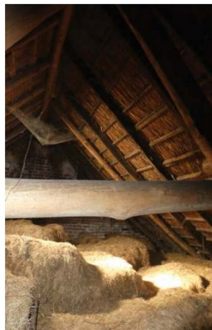
Dakconstructie boven stal met enkele oude beroette eiken daksporen.
