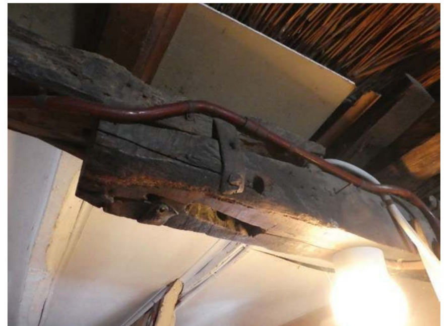
Oorspronkelijk eind van de gebintplaat op str. 3
