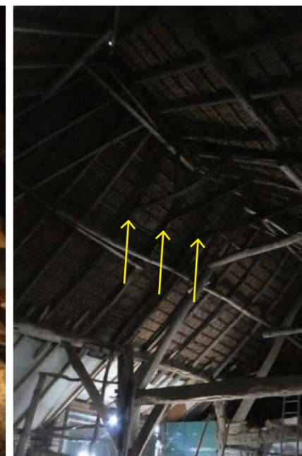
Dakconstructie boven schuur met enkele oude beroette eiken daksporenparen met hanebalk.
