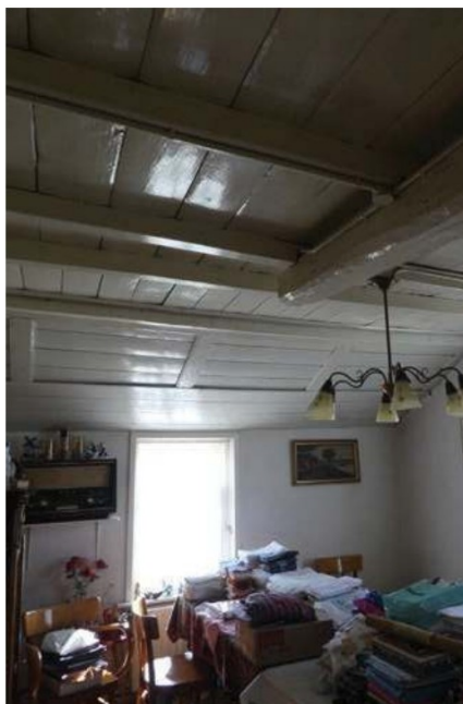
Houten betimmering en uiteinde van moerbalk.
