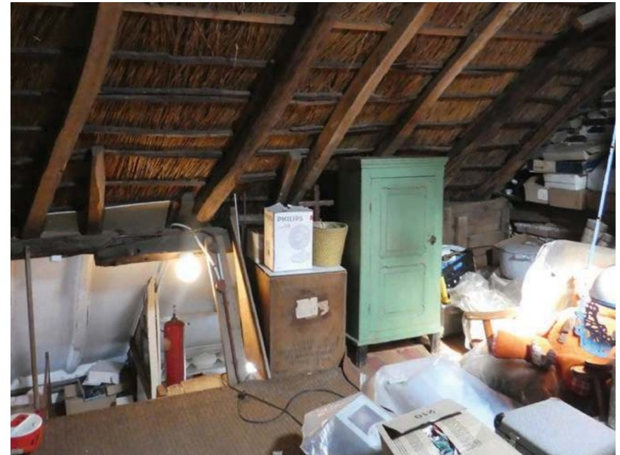
Gebintplaat op str. B. boven het woonhuis.
