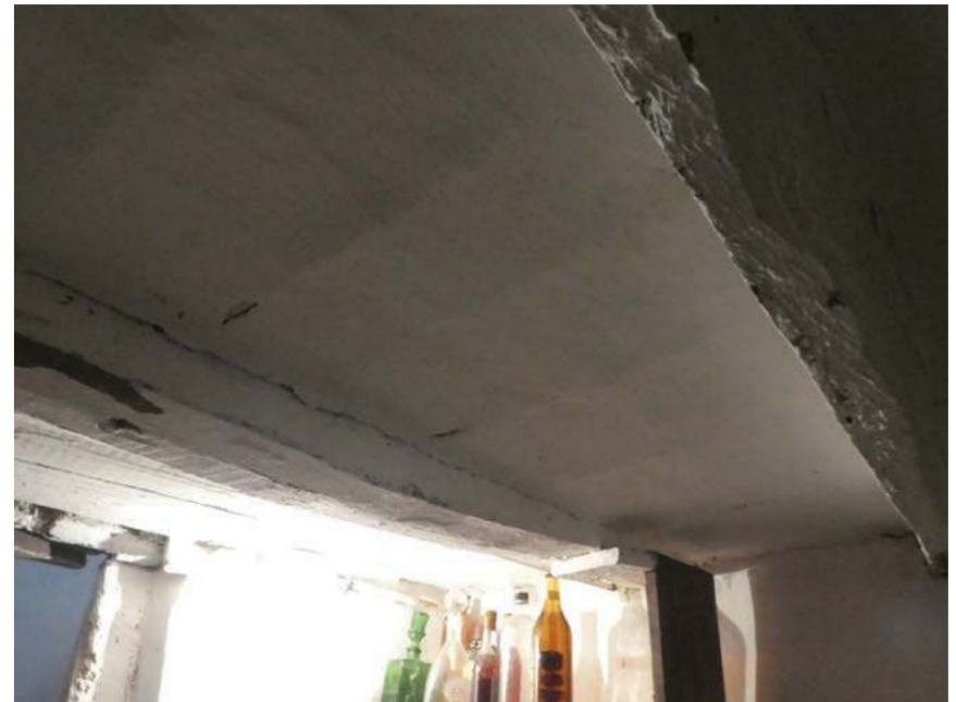
Detail van spelderwerk tussen vloerbalken.
