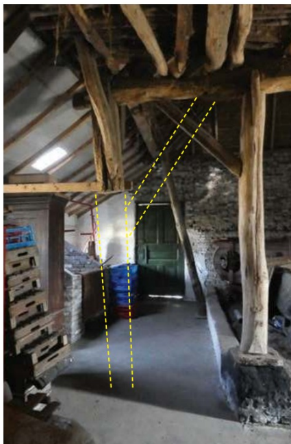
Afgezaagde gebintstijl B7, op de achtergrond schuingeplaatste stijl B8. In geel de reconstructie van stijl en korbeel.
