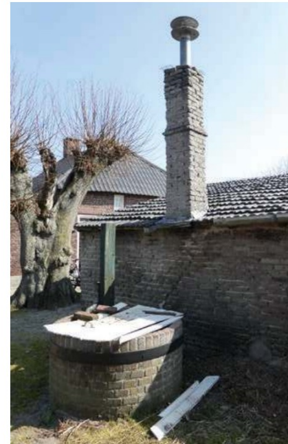
Detail van waterput en schoorsteen van het wasformuis in het kippenhok.
