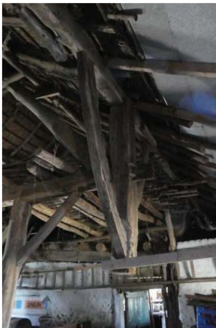
Afgezaagde gebintstijl B7 met oorspronkelijke 'staande' schoren.
