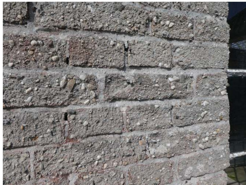
Kippenhok, detail van oorspr. gerooid metselwerk van grove cementsteen.
