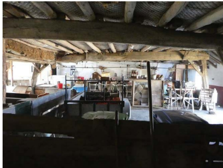
Overzicht op stalruimte, gezien richting de voorstal.
