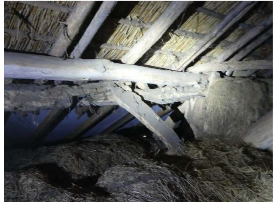
Samenkomst van oude elken gebintplaten (str. C) boven gebintvak 5-6 en bijgeplaatste plaat..
