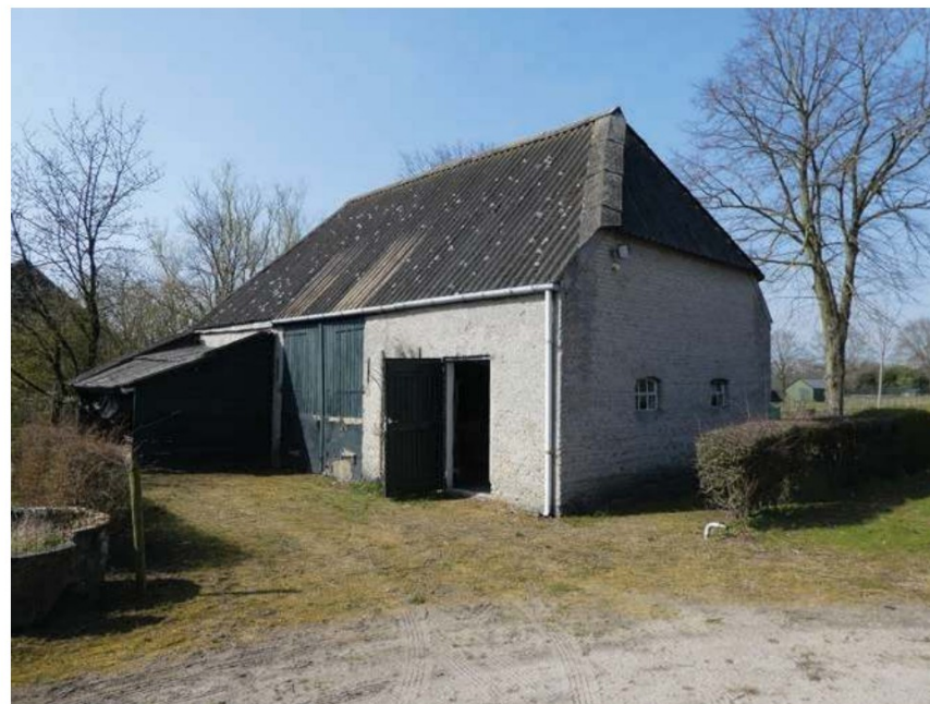
Dwarsdeel-schuur, aanzicht vanaf het erf.
