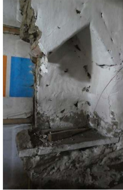
Detailfoto's van kaarsnis in scheidingsmuur tussen stal en schuur.
