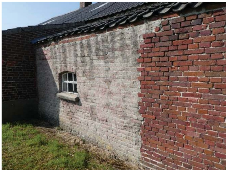
Dichtgezette potstal deur met (oorspronkelijk gerode) cementsteen.
