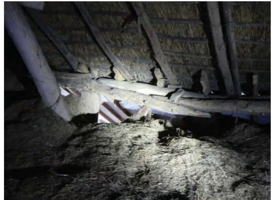
Samenkomst van oude elken gebintplaten (str. B) boven gebintvak 5-6 en bijgeplaatste plaat..
