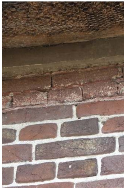
Herstellingen onder de muurplaat: met gerede cementsteen.
