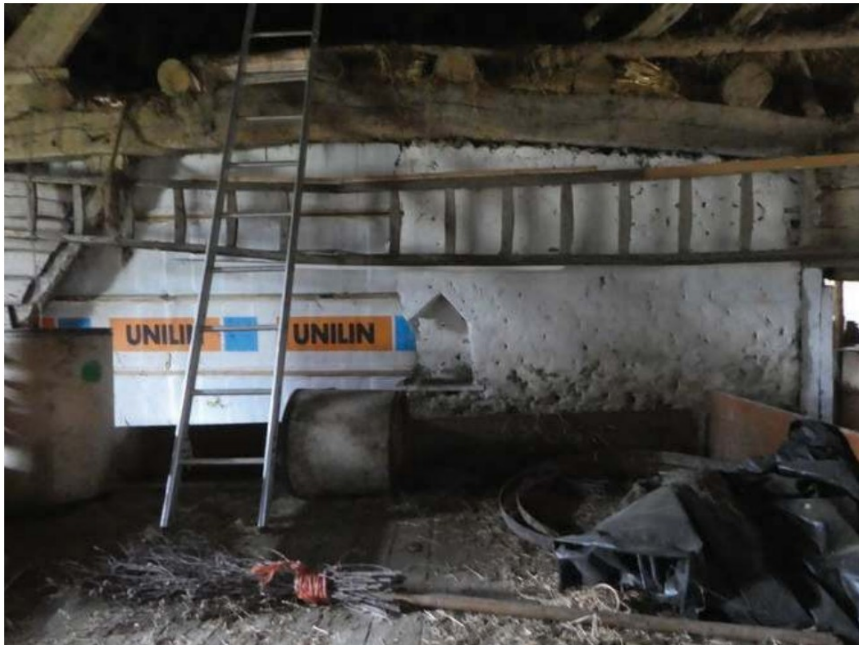
Scheidingsmuur tussen stal en schuur met centraal een kaarsnis (linker deel is weggevalen).
