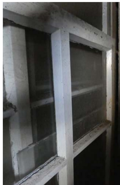
Detail van originele ramen.
