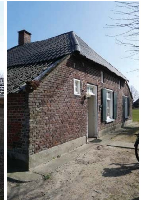
Voor- of zuidwestgevel.
