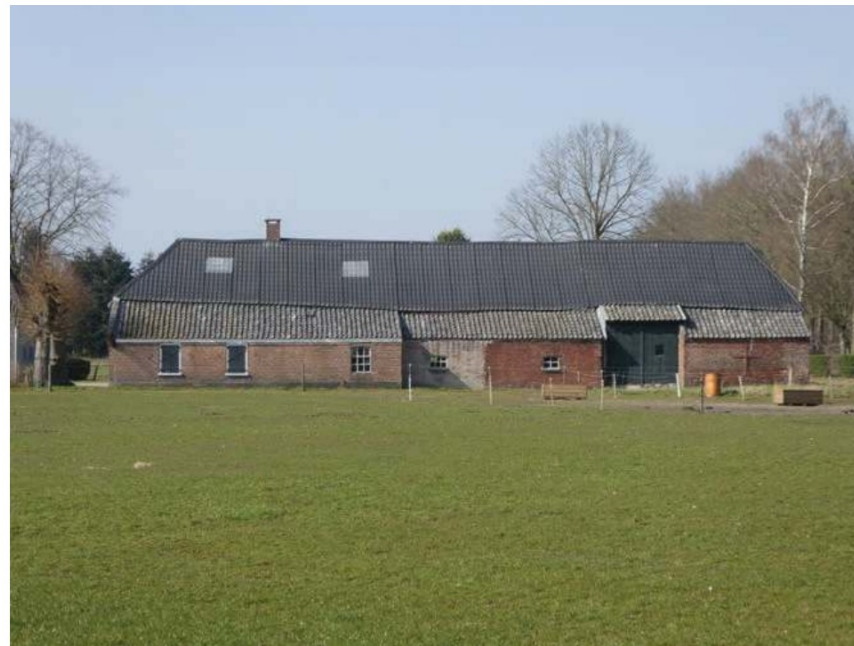
Overzicht van zuid-oostgevel.
