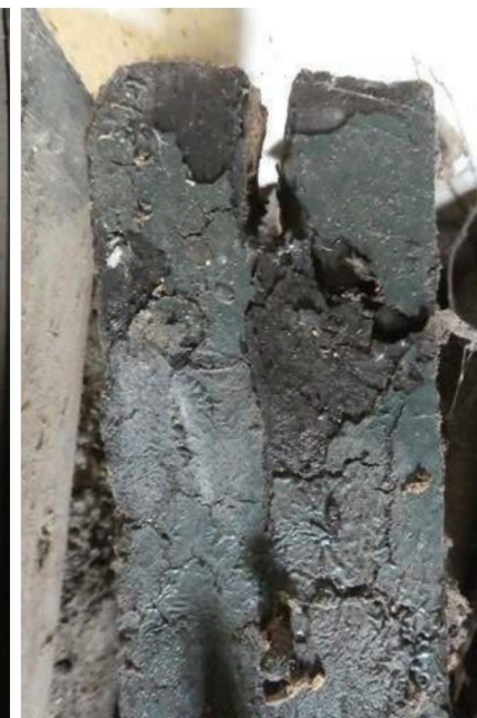
Detail van bewaarde kozijnstijl van potstaldeur.
