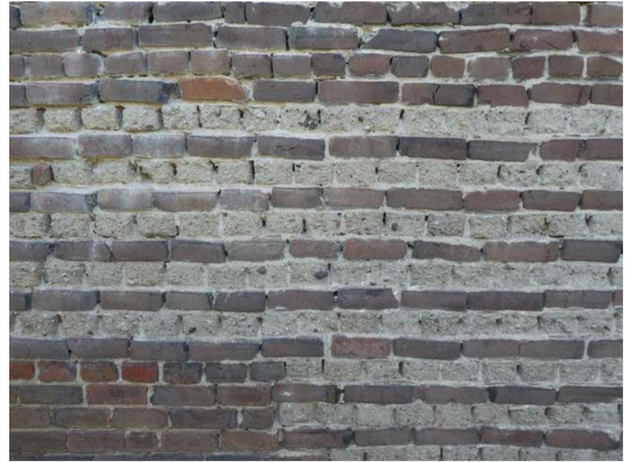
Detail van metselwerk in zijgevel.
