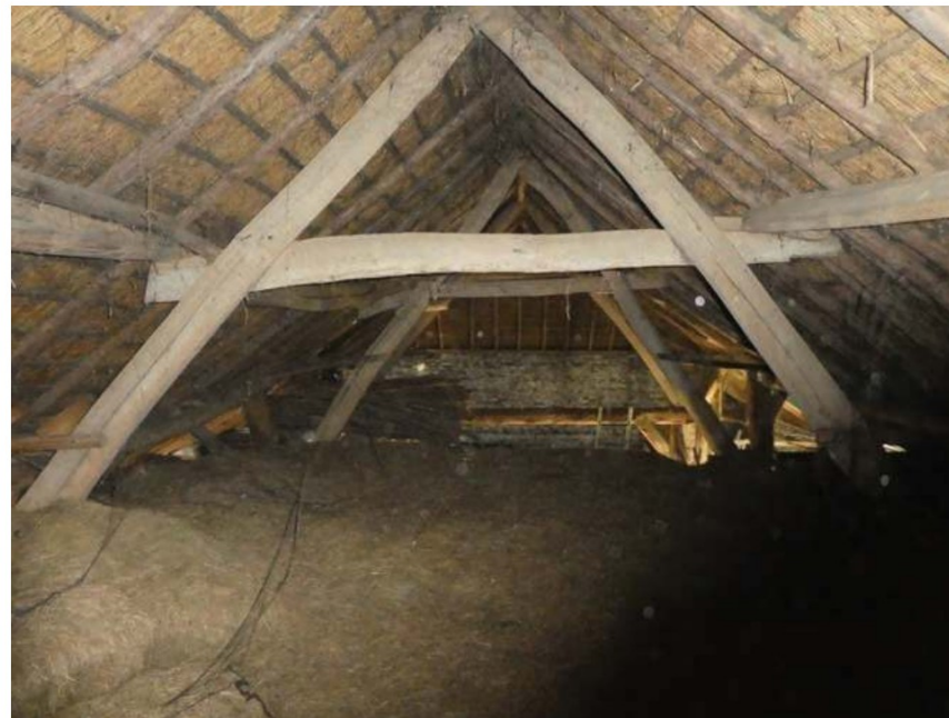
Dakconstructie boven stal.
