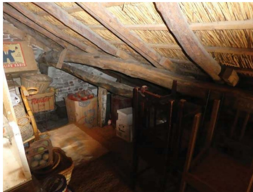
Gebintplaat / gording op str. C. boven het woonhuis.
