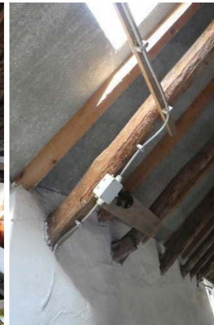
Dubbele dakconstructie (oud en nieuw) in stal.
