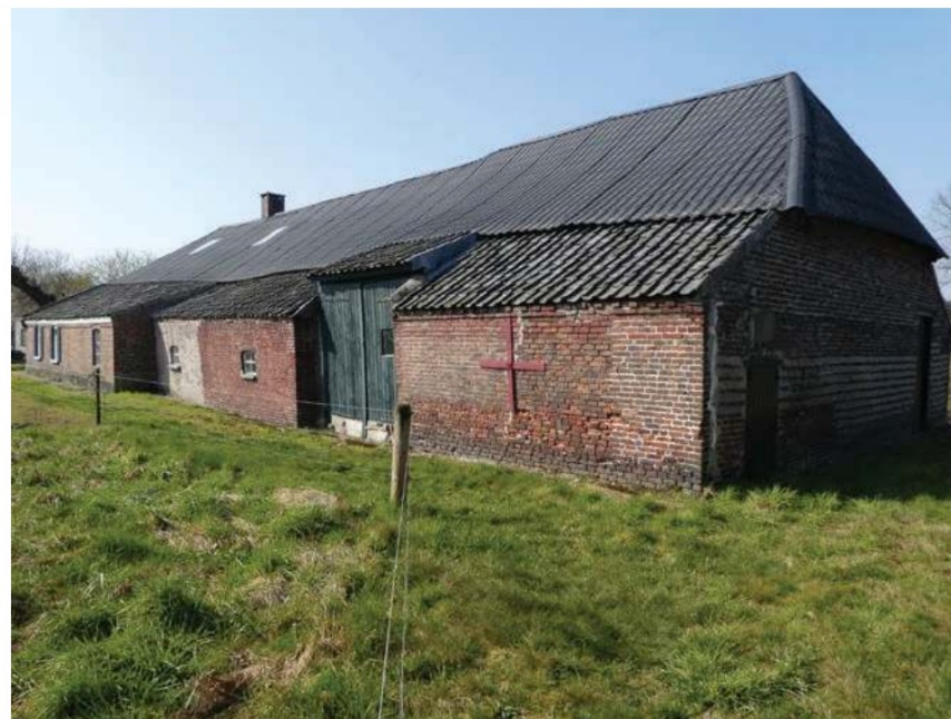
Rechterzijde van zuid-oostgevel.
