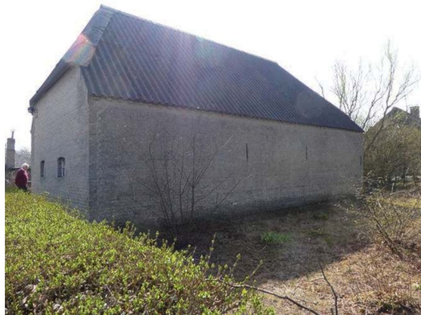
Dwarsdeel-schuur, aanzicht vanaf de straat.
