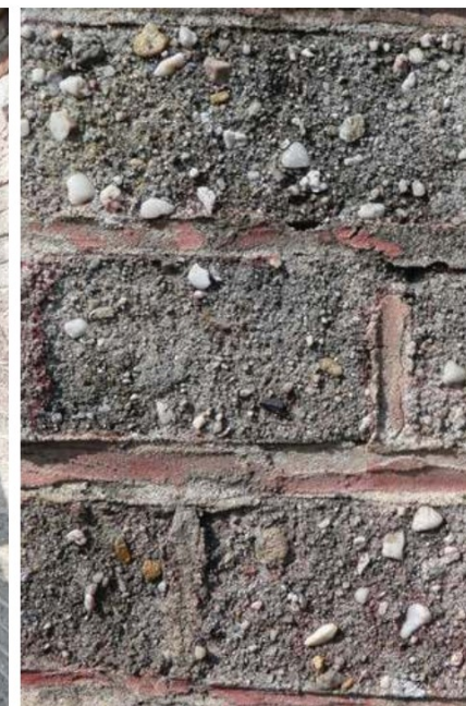
Detail van cementsteen metselwerk met restanten van rode afwerking.
