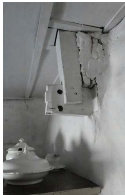
Ondersteuning van gebintplaat (str. B) op uiteinde van haardbalk (pen met bouwsporen van verbinding met stijl.)
