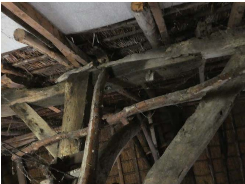
Fraaie las met toognagels en wig nabij gebintstijl C7. De linker schoor is t.b.v. de doorrit in tweede instantie hoger aangebracht.
