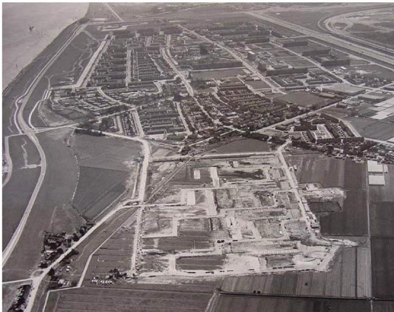
uitbreidingswijk 'Vogelbuurt' in aanbouw 1970, dwars door de aangelegde polderstructuur
