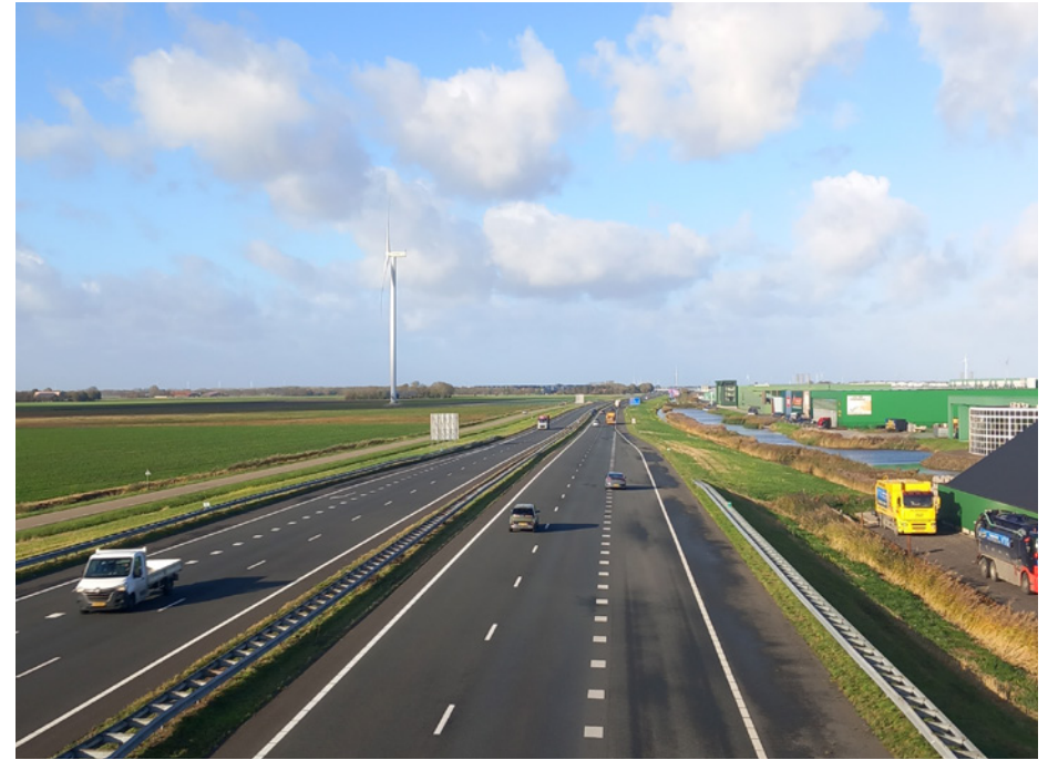
Zicht op de A7 ter hoogte van bedrijventerrein Agriport, met bedrijven rechts en de grote openheid links van de snelweg
