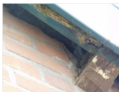
Figuur 5.28 Ruimte bij het dak van de schuur (gebouw 4).
