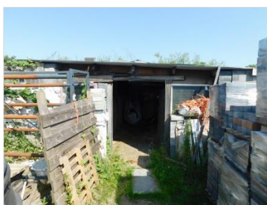
Figuur 2.21 Schuur met paardenstal (gebouw 11).
