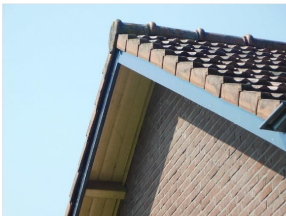
Figuur 5.8 Zadeldak met overhangende kantpannen en nokvorst van de woning (gebouw 9).
