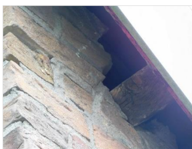
Figuur 5.27 Ruimte onder het dak van het entree gebouw (gebouw 6).
