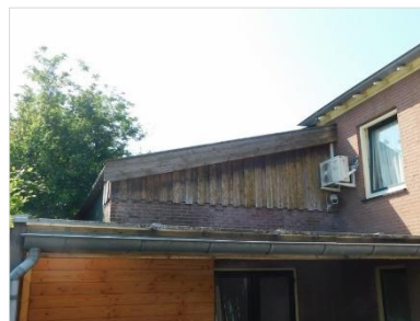
Figuur 5.31 Betimmering met bij het gedeelte van de paardenstal (gebouw 10).
