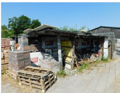
Figuur 5.36 Schuur op het terrein (gebouw 11).
