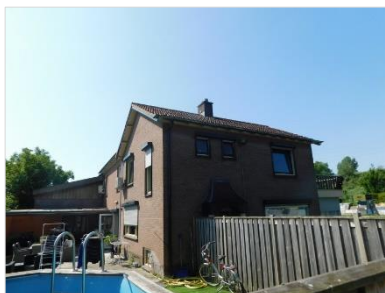
Figuur 2.18 Woonhuis (gebouw 9) op deelgebied E.
