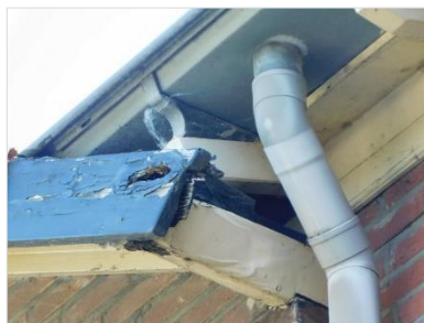
Figuur 5.30 Openingen bij de dakrand, woning (gebouw 9) deelgebied E.
