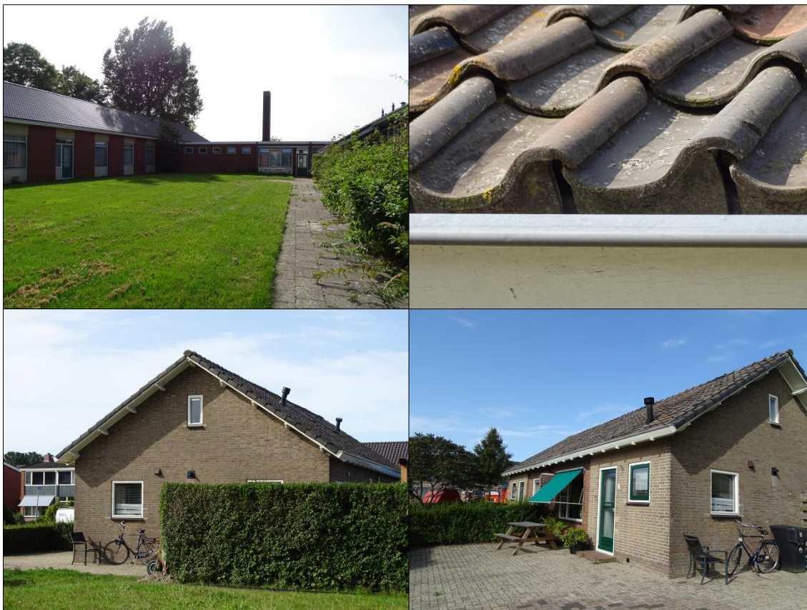
Foto's 9 - 12. Linksboven het aanzicht op de ruimte tussen het Groene Kruis-gebouw (links) en het dorpshuis (rechts). Rechtsboven het pannendak van het dorpshuis met ruimtes. Linksonder de zuidelijke te slopen woning vanuit het zuiden. Rechtsonder de twee te slopen woningen vanuit het zuidwesten.
