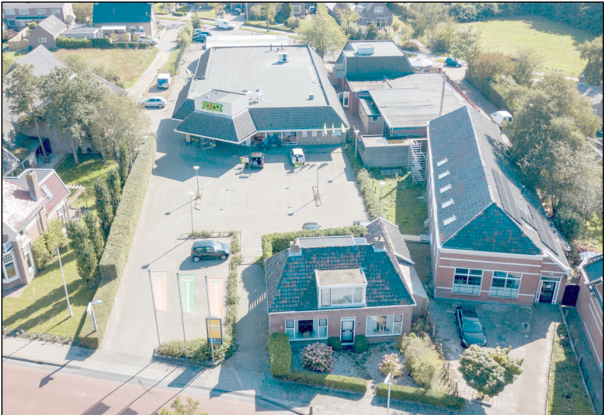
Figuur 5. Bebouwing Hôfsleane, gezien vanaf de Hôfsleane (bron: Poiesz)
