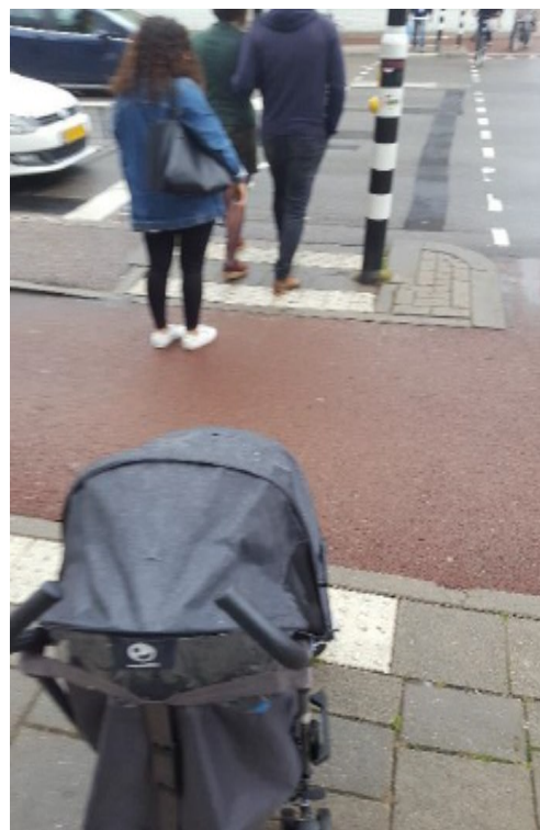
Foto 2: beperkte opstelruimte voetgangers t.h.v. ASW 423
