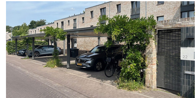
Strijp S | Eindhoven: pergola en schuur ontworpen in architectuur woning
