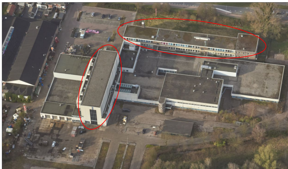
Afbeelding: voormalig kantoor Tubantia (boven) en drukpershal (links)
