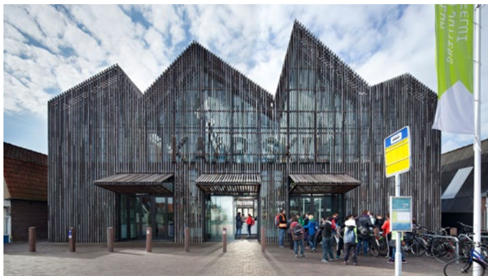
'traditionele' gebouwworm met eigentijdse materialen en verfijnde detaillering
