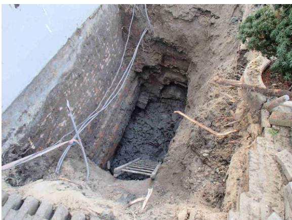
Inspectieput tijdens onderzoek
