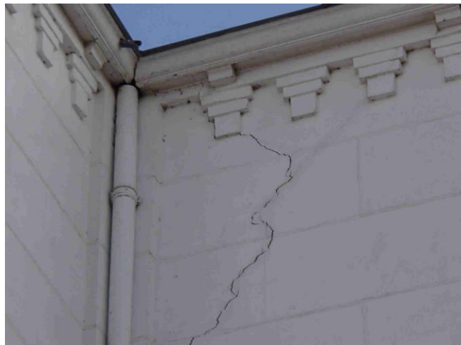
Kerk rechter uitbouw, zware scheur verticaal
