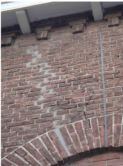
Gevel kerk boven pastorie, zware scheur getrapt door verzakking
