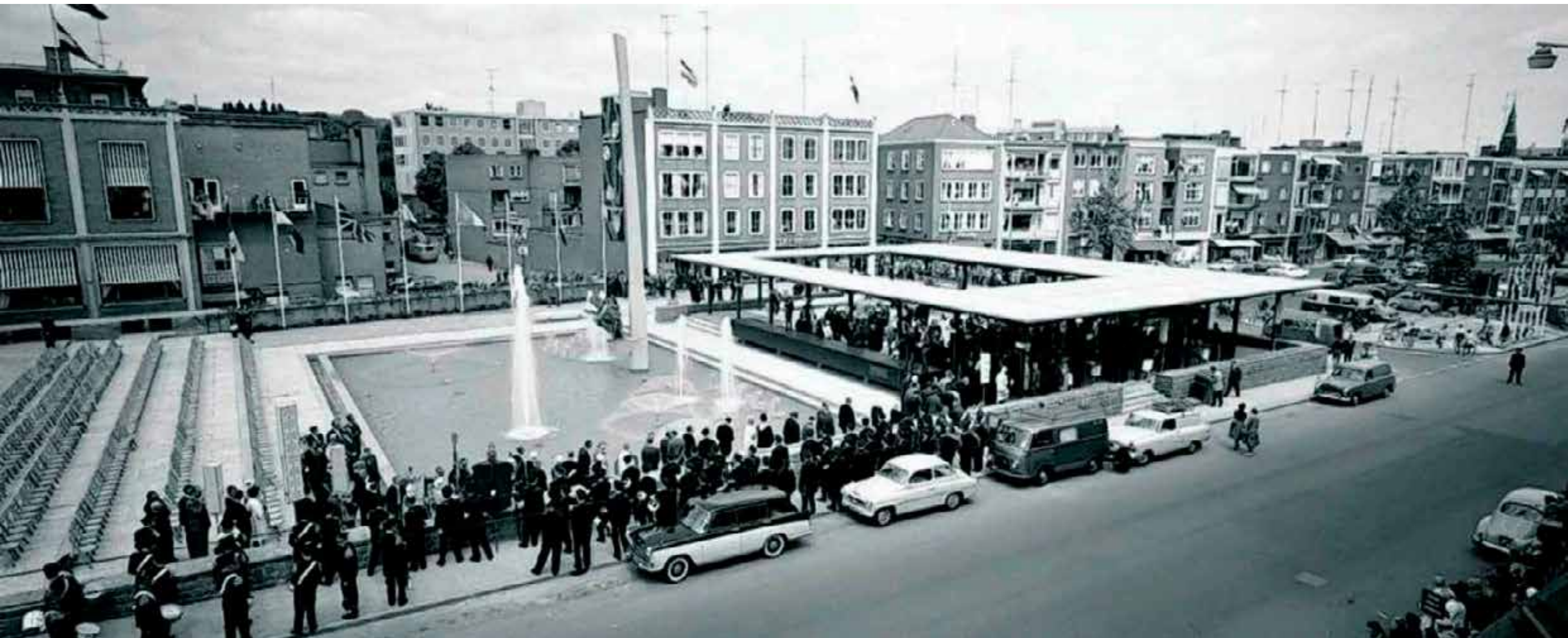
oorspronkelijke situatie met de verkeersweg aan de zuidzijde van de Aku-fontein en de basaltmuur als afscheiding
