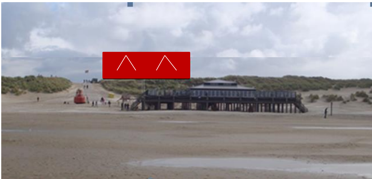
Montage van de zeezijde
