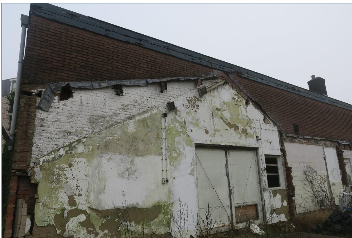
Figuur 2 De loods bestaat uit gemetselde muren met spouw en betreft een plat dak.
