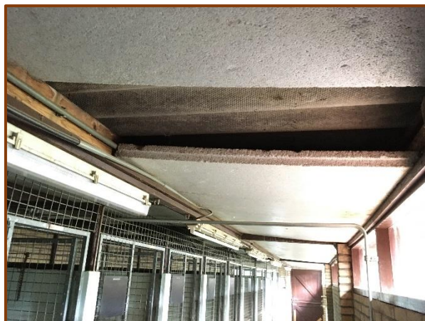
Figuur 2.3: afgesloten ruimte onder het dak
