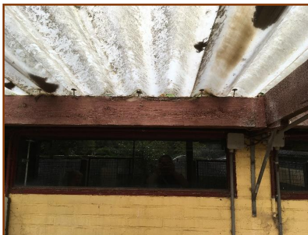
Figuur 2.4: golfplaten dak
