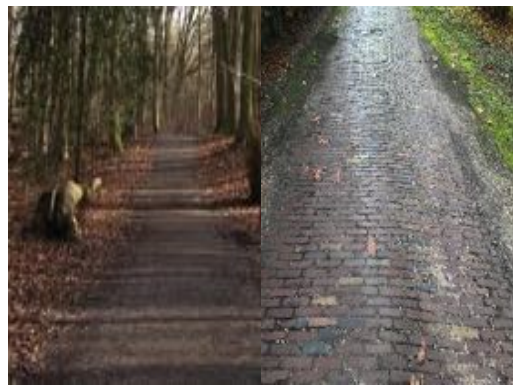
16 De inrit wordt vanuit de bestaande verharde toegangsstroken omgevormd naar een meanderende halfverhard pad
