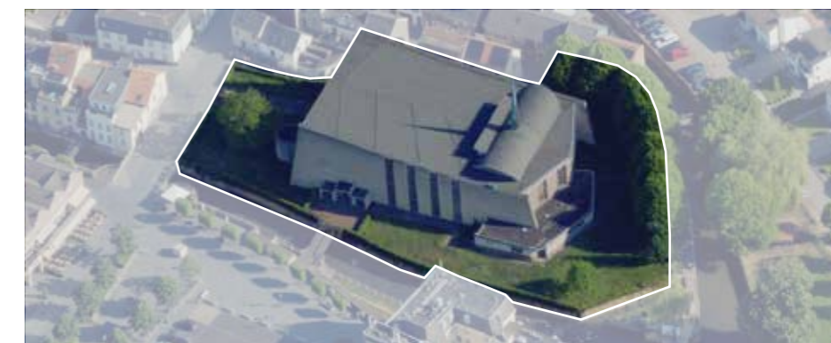
Bestaande situatie Nieuwe Kerk, Valkenburg-Oost
