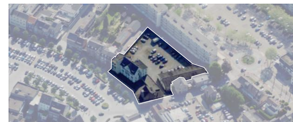
Bestaande situatie locatie Hotel Palanka, Valkenburg Oost
