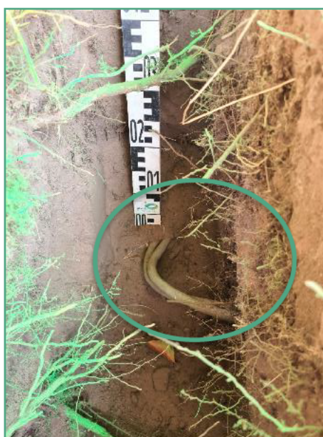
Afbeelding 3.13 Kabel in profielsleuf 2
