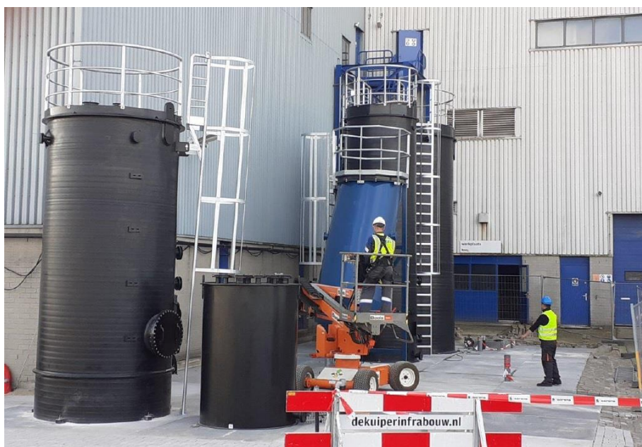
Figuur 35. Bioplastics fabriek in aanbouw op locatie HVC Dordrecht.
