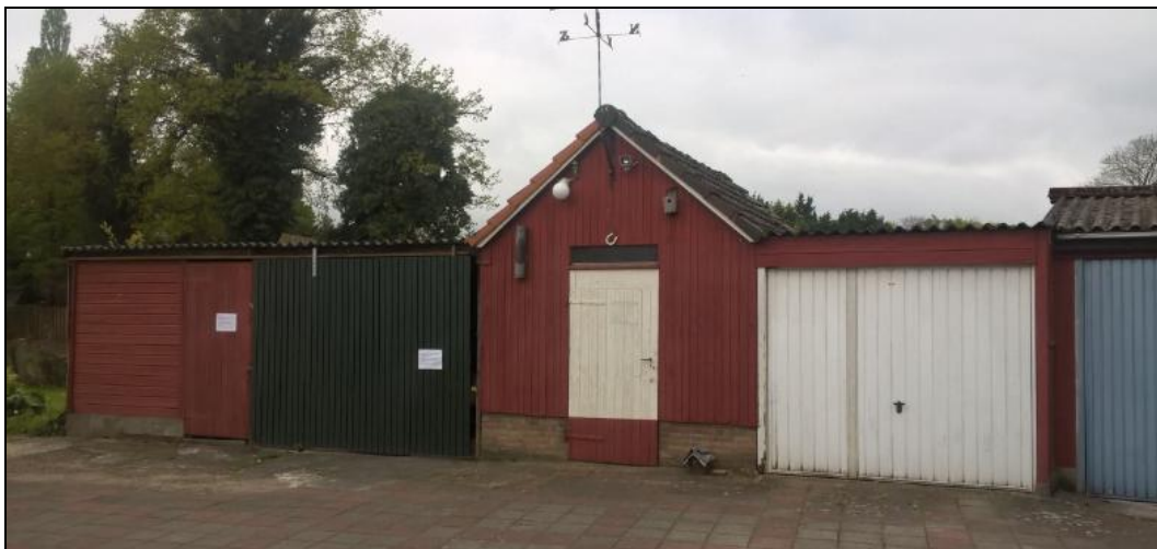
Figuur 4.1-1: Te slopen schuren/garages in het plangebied.
