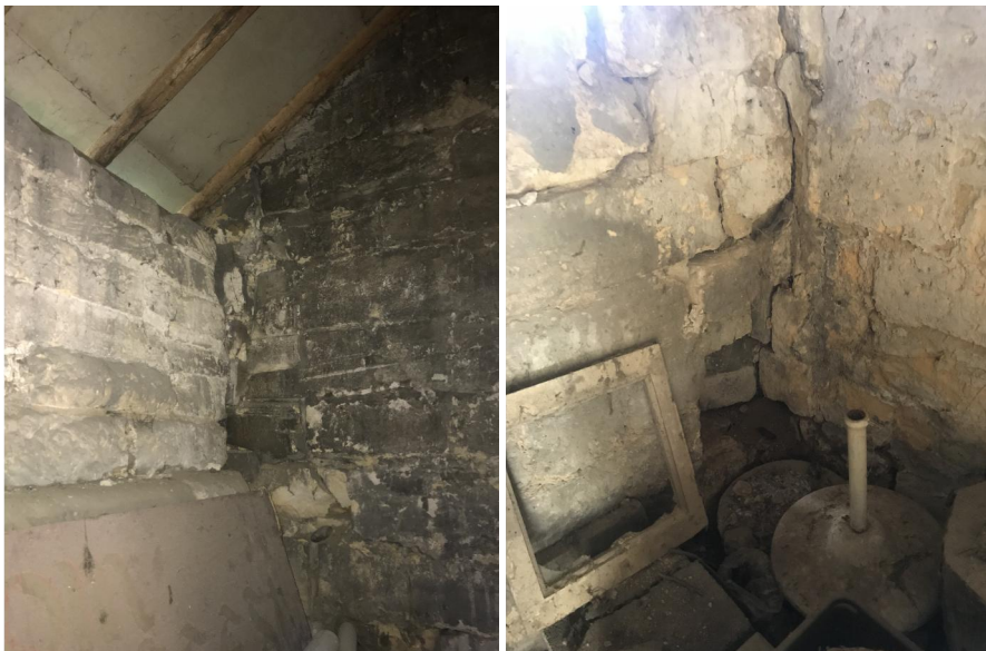
Foto 7 en 8: Geen verankering en vertanding tussen wanden met scheefstand en wand vierkante toren aanwezig.
