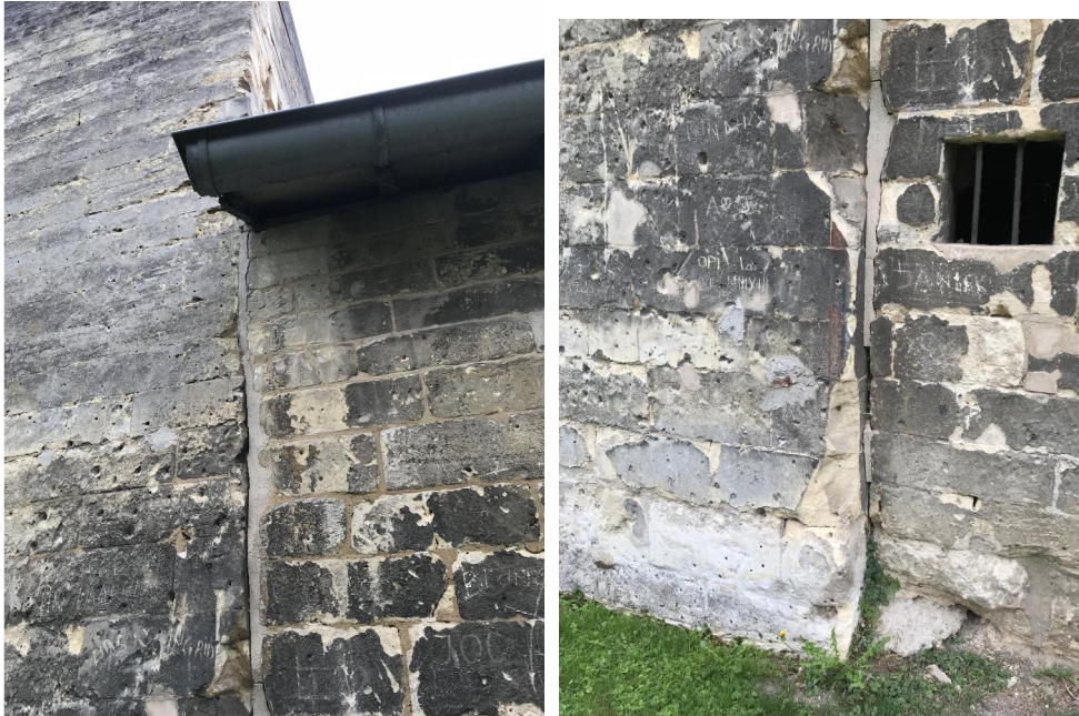
Foto 5 en 6: Staande voeg tussen schuine gevel en vierkanten toren.
