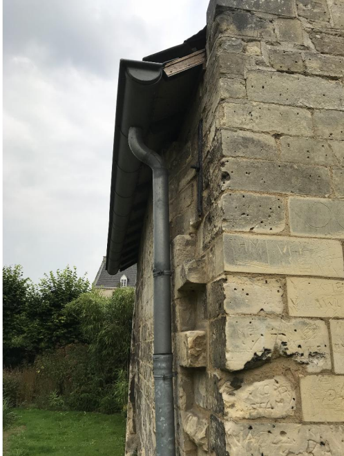
Foto 2 en 3: Anker tbv stabiliseren gevel uit het lood en nieuwe gevelstenen tpv aansluiting met stadswal.
