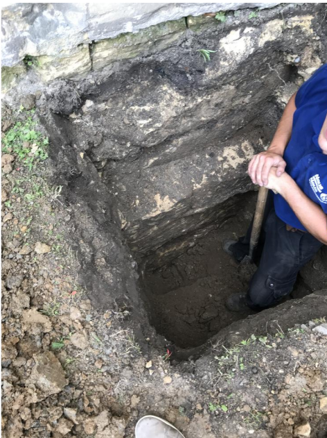
Foto 12: Onderzijde fundering zijgevel nog niet bereikt op 1,80m-maaiveld
