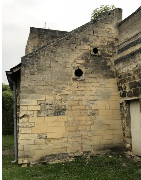
Foto 2 en 3: Anker tbv stabiliseren gevel uit het lood en nieuwe gevelstenen tpv aansluiting met stadswal.
