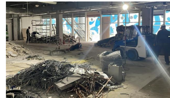
Aanleg walstroom zeecruise
