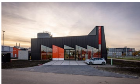
Warmtecentrale WarmteStad in Groningen
