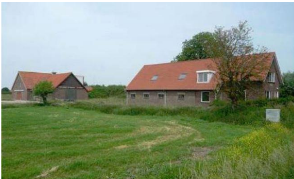
Zijaanzicht plangebied huidige situatie (extra agrarische bedrijfsbebouwing en Hoeve de Boe)
