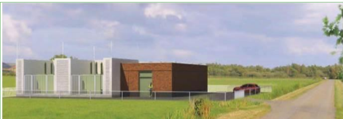
Figuur 2. Algemene impressie van een standaard transformatorstation.
