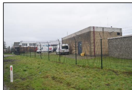
Bebouwing op onderstation.
